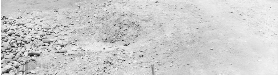
圖13 麥克阿瑟公路施工情形
