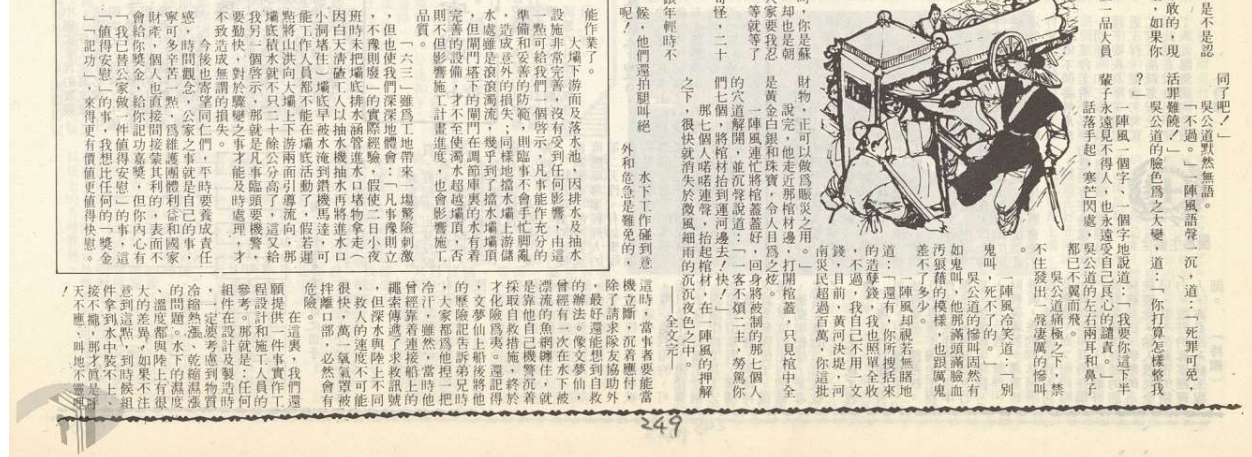
圖10 在過港隧道完工後，《榮工報導》刊出潛水班回憶施工過程
