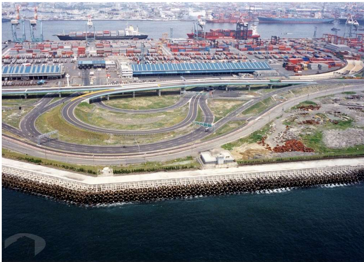
圖6 過港隧道完工後，過港隧道旗津端與引道、第四貨櫃純運中心的相對位置
