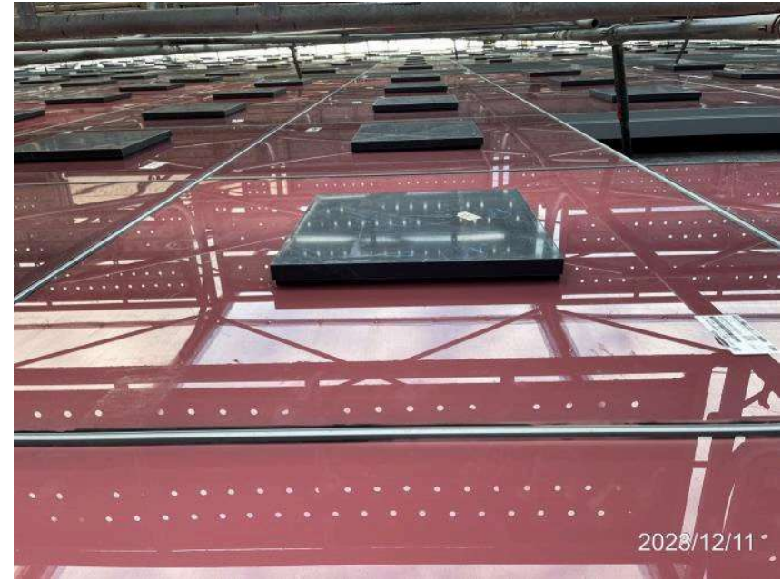
外牆玻璃帷幕完成面
