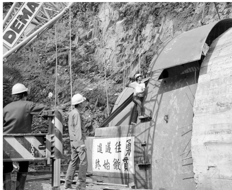
圖14 工人正進行北迴鐵路隧道岩壁架設工程
