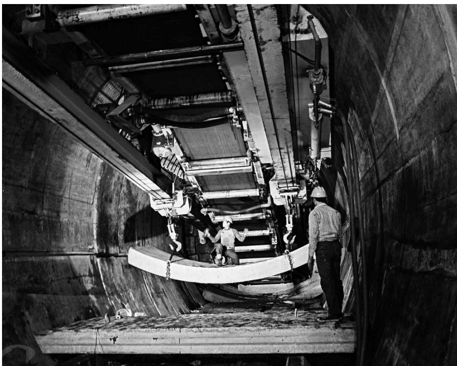
圖13 工人操作著大約翰進行開挖隧道
