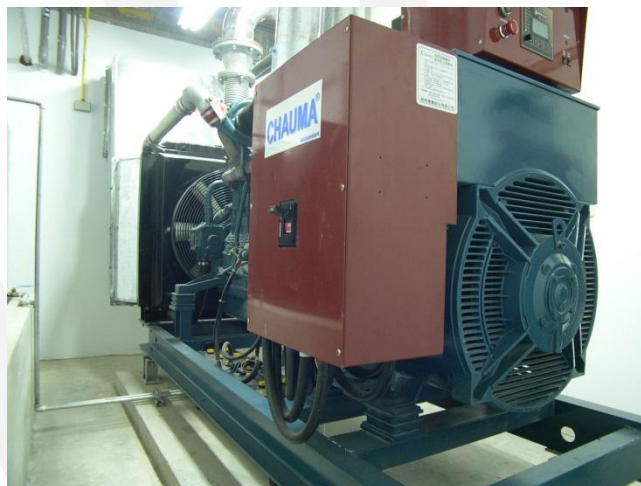
圖35 緊急發電機
