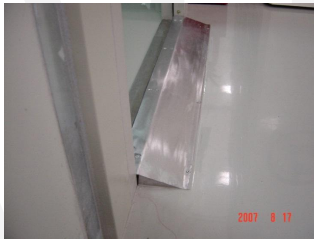
圖14 不鏽鋼緩坡處理方式
