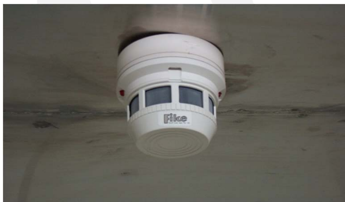
圖32 偵煙探測器
