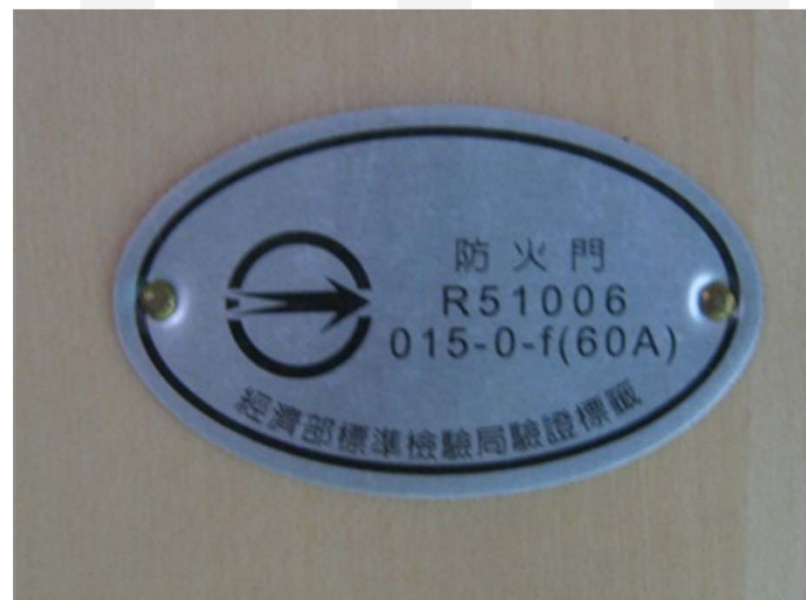
圖11 具1小時以上防火時效「f ( 60A ) 」門窗的認證參考圖樣
