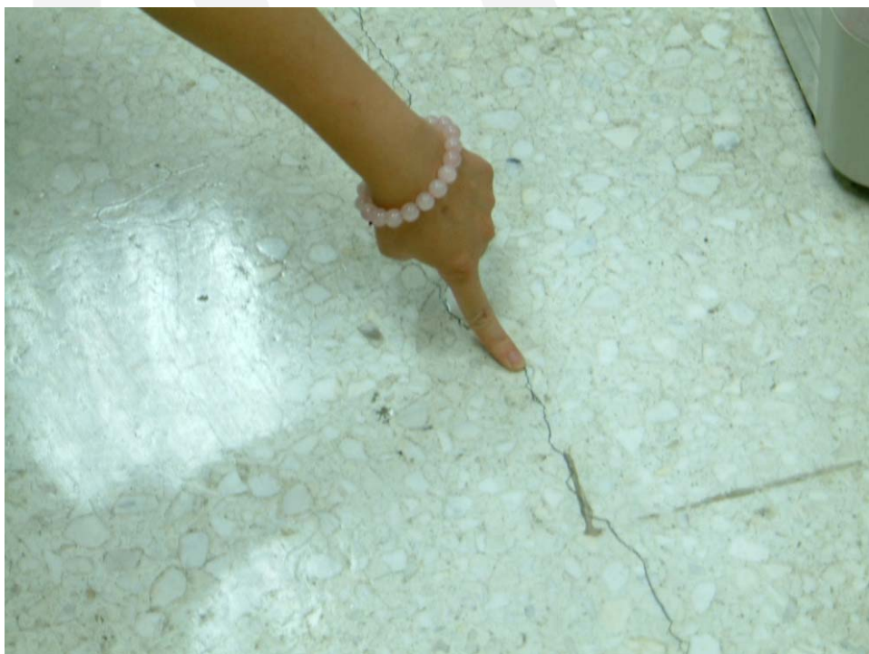
地板超載產生裂縫之情形(不良案例)
