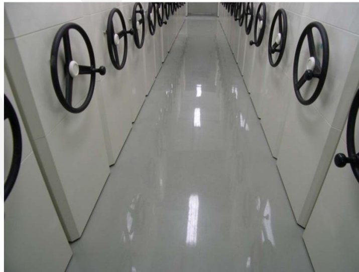
圖12 環氧樹脂(EPOXY)地坪
