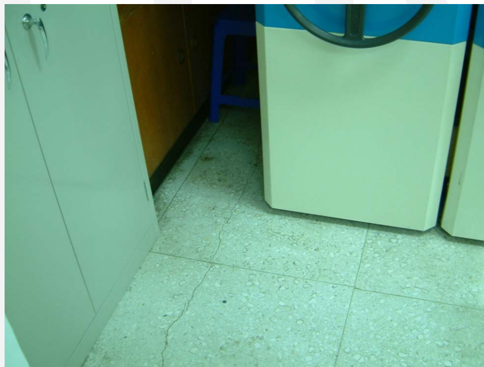
地板超載產生裂縫之情形(不良案例)
