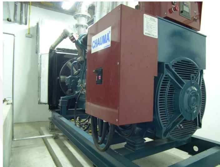
圖35 緊急發電機
