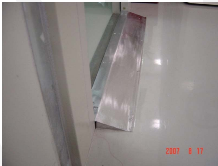
圖14 不鏽鋼緩坡處理方式
