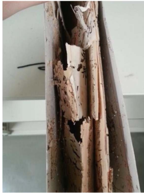
嚴重蟲蛀、腐朽/沾黏，已多處成小碎片
