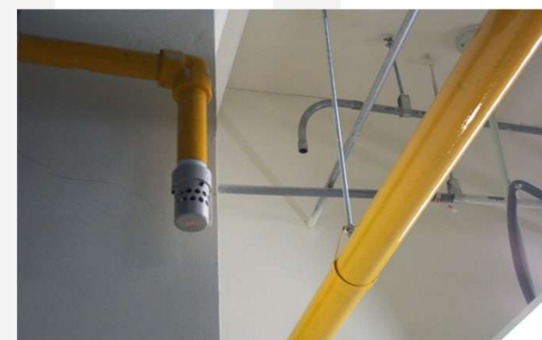
圖34 氣體式自動滅火設備(左上：控制盤、右上：氣體鋼瓶、 左下：黃色氣體管線、右下：氣體噴頭)
