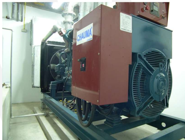
圖35 緊急發電機
