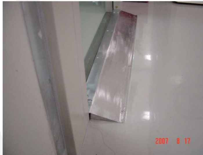
圖14 不鏽鋼緩坡處理方式
