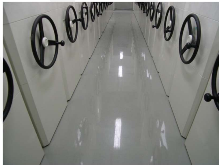
圖12 環氧樹脂(EPOXY)地坪
