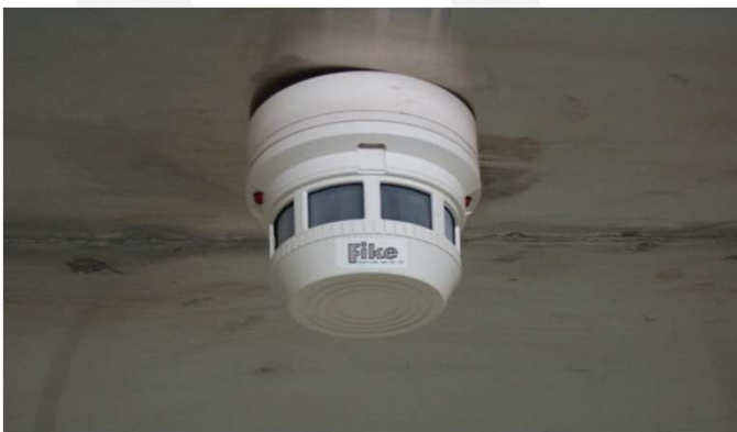
圖32 偵煙探測器
