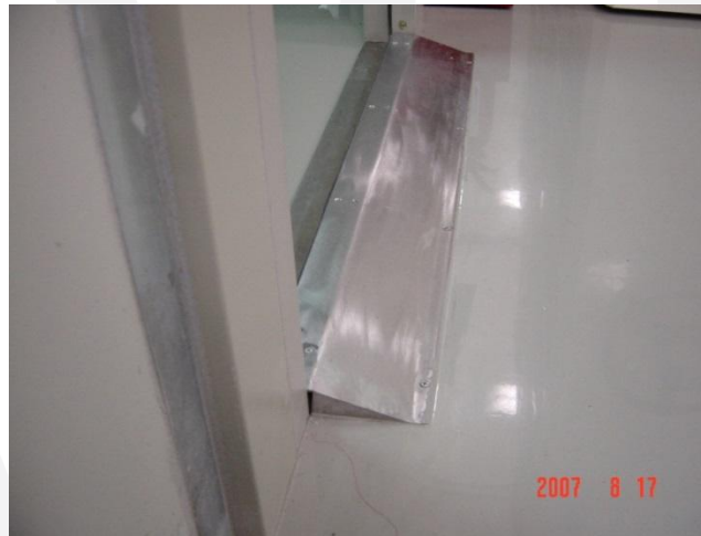
圖14 不鏽鋼緩坡處理方式
