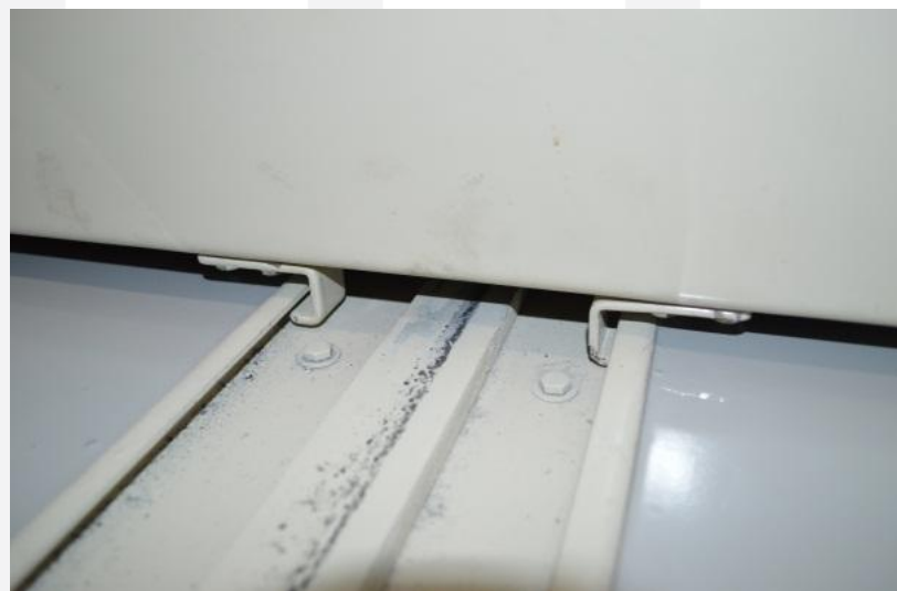
圖39 密集式檔案架防傾倒卡榫
