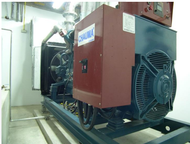
圖35 緊急發電機
