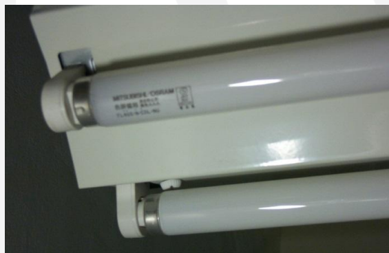
圖19 濾紫外線套管
