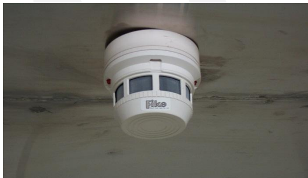
圖32 偵煙探測器
