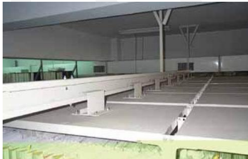
圖38 密集式檔案架防傾倒連桿
