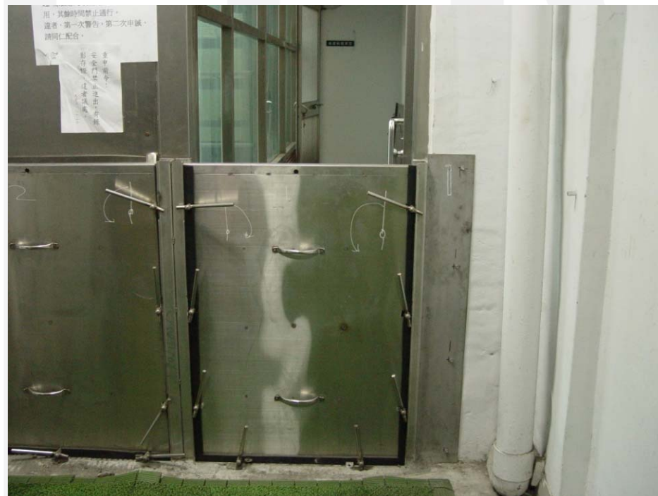
防水閘門(左圖：裝設前；右圖：裝設後)
