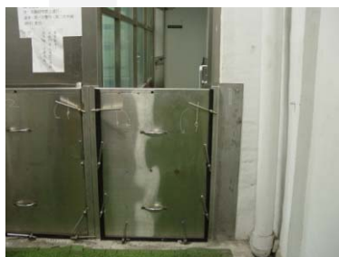
防水閘門(左圖：裝設前；右圖：裝設後)
