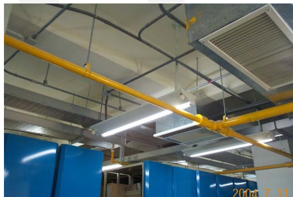
氣體式自動滅火設備
