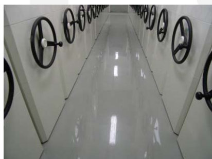
環氧樹脂(EPOXY)地坪
