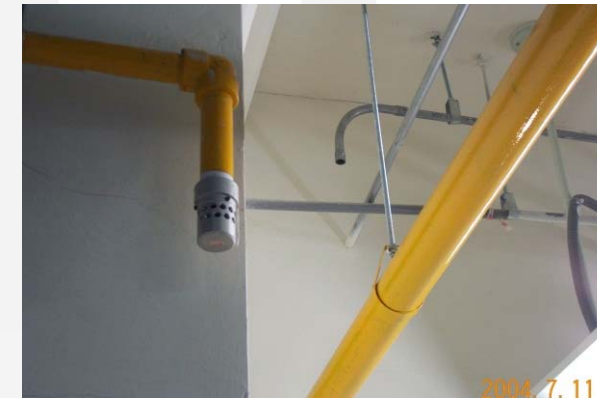
氣體式自動滅火設備
