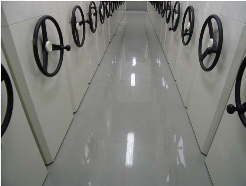
環氧樹脂(EPOXY)地坪
