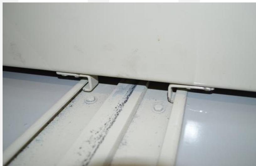
圖39 密集式檔案架防傾倒卡榫
