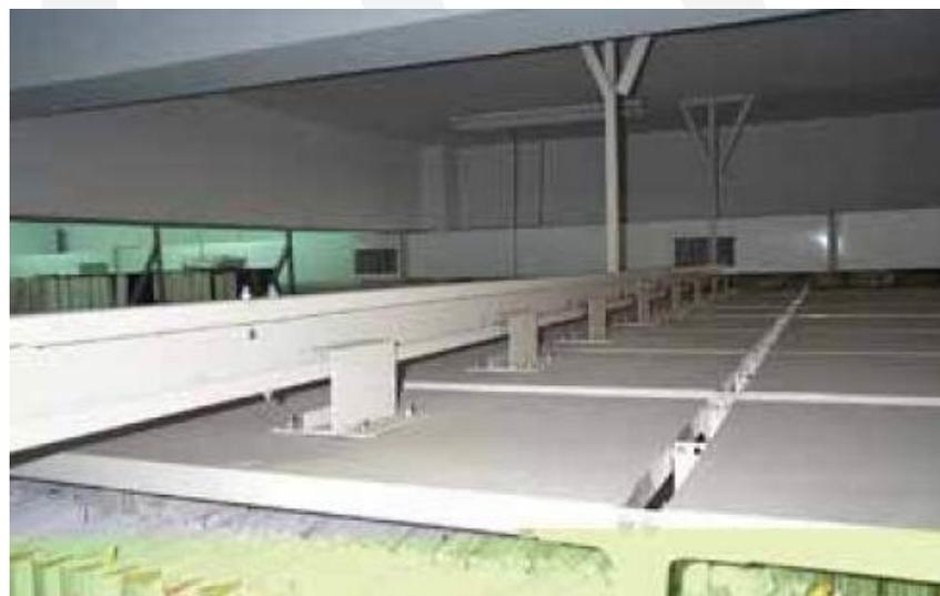
圖38 密集式檔案架防傾倒連桿
