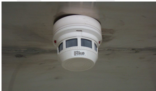
圖32 偵煙探測器
