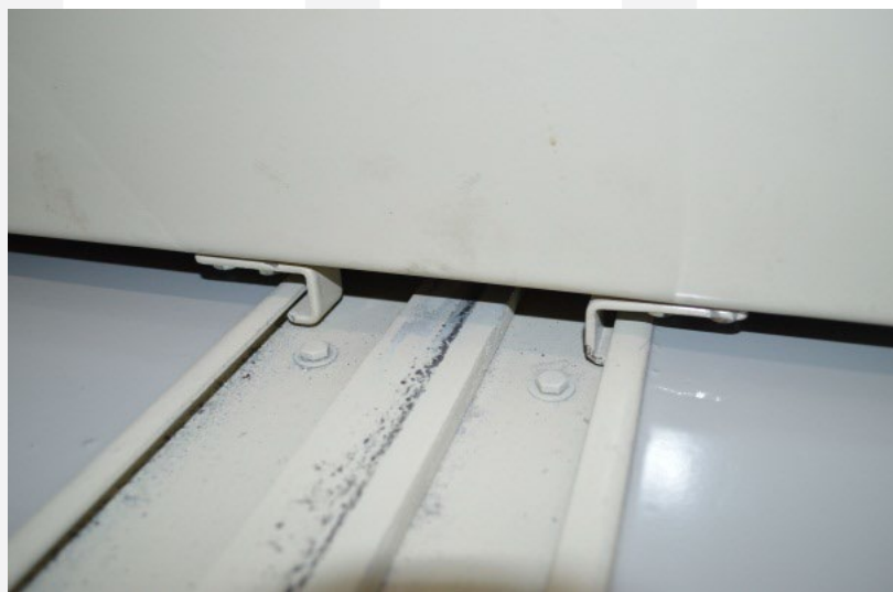
圖39 密集式檔案架防傾倒卡榫
