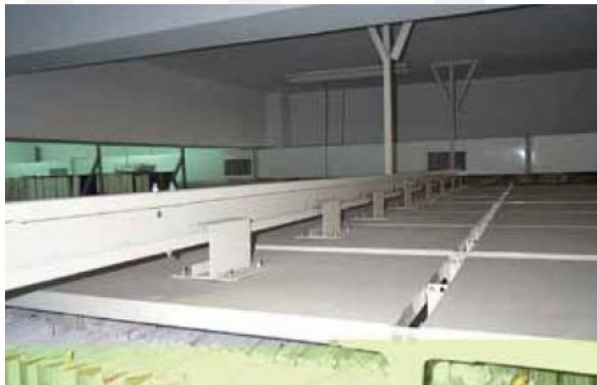
圖38 密集式檔案架防傾倒連桿
