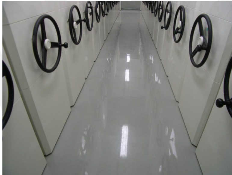
圖12 環氧樹脂(EPOXY)地坪
