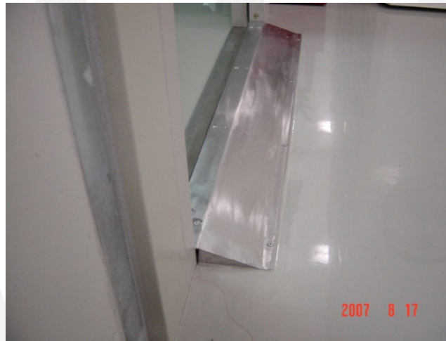
圖14 不鏽鋼緩坡處理方式
