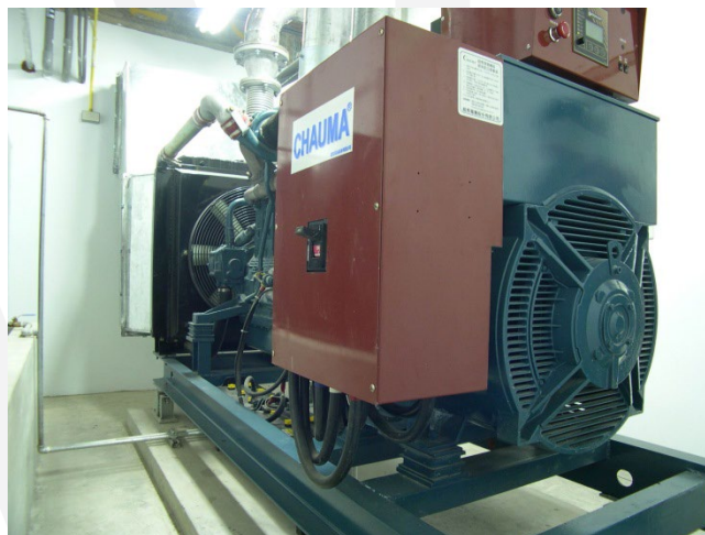
圖35 緊急發電機
