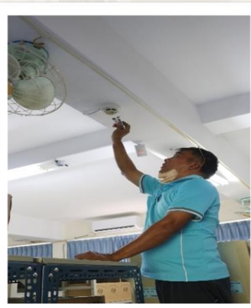
檔案庫房偵煙設備測試
