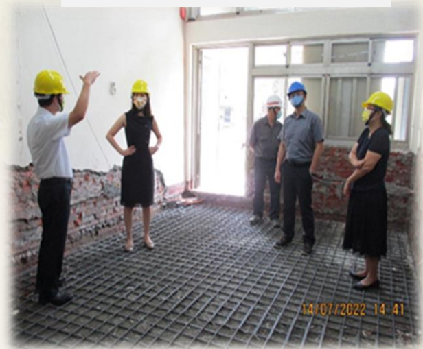
工程施作補強地基
