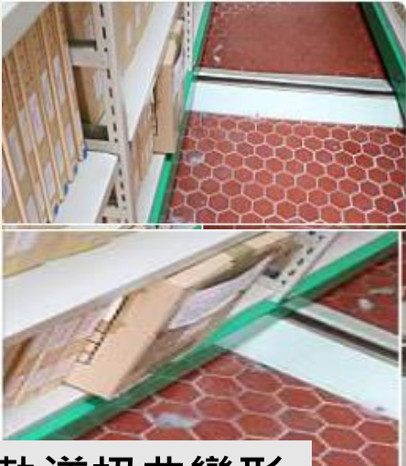
磁磚龜裂毀損、軌道扭曲變形
