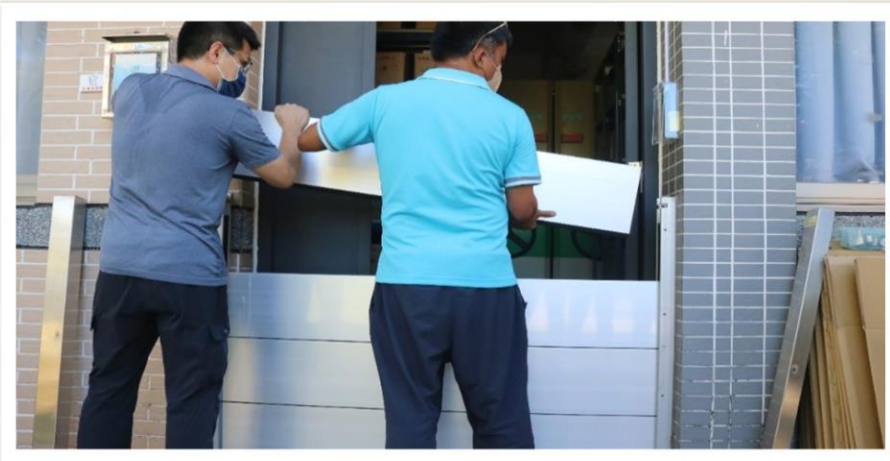
檔案庫房防水閘使用
