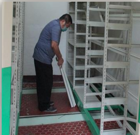
磁磚龜裂毀損、軌道扭曲變形
