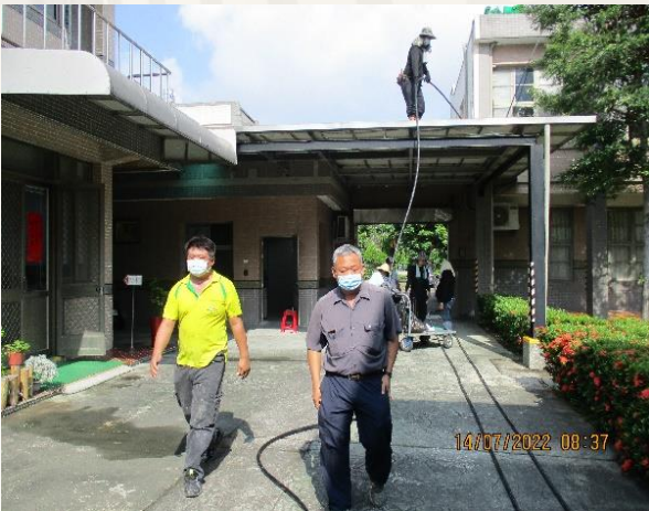
改善電力設施
