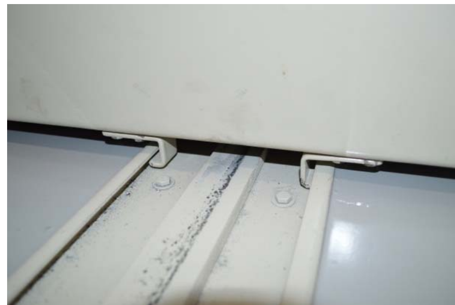
密集式檔案架防傾倒卡榫
