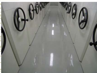
環氧樹脂(EPOXY)地坪
