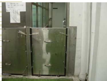
防水閘門(左圖：裝設前；右圖：裝設後)
