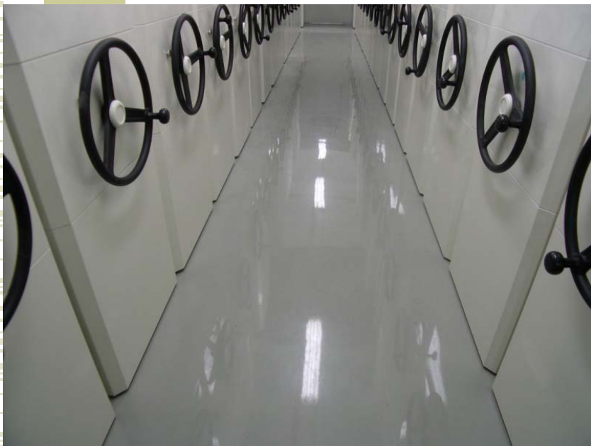
環氧樹脂(EPOXY)地坪
