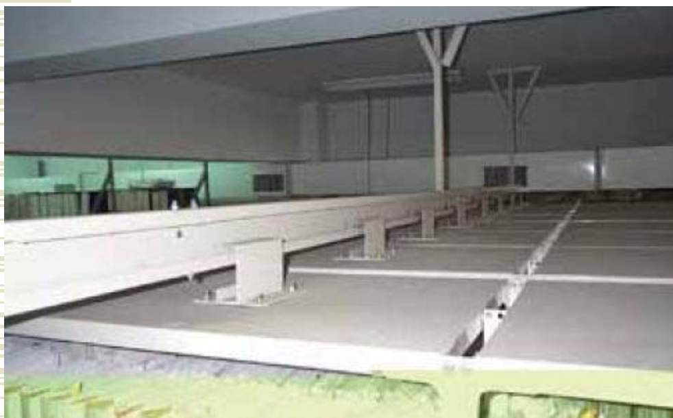
密集式檔案架防傾倒連桿
