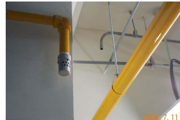
氣體式自動滅火設備 (左上：控制盤、右上：氣體鋼瓶、 左下：黃色氣體管線、右下：氣體噴頭)
