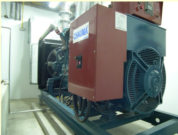
圖35-緊急發電機
