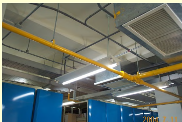
圖34-氣體式自動滅火設備(左上：控制盤、右上：氣體鋼瓶、 左下：黃色氣體管線、右下：氣體噴頭)
