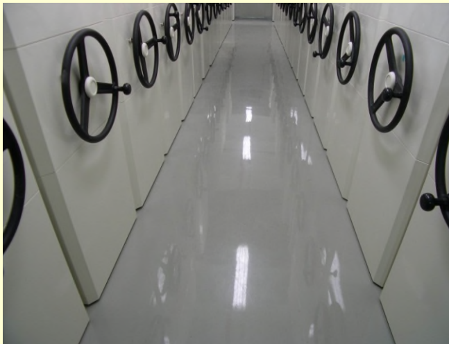
圖12-環氧樹脂(EPOXY)地坪
