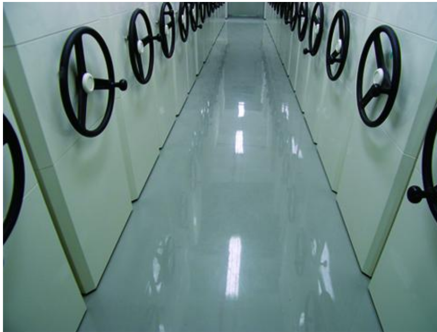
圖2 符合規定無裂縫的地板(適當案例)
