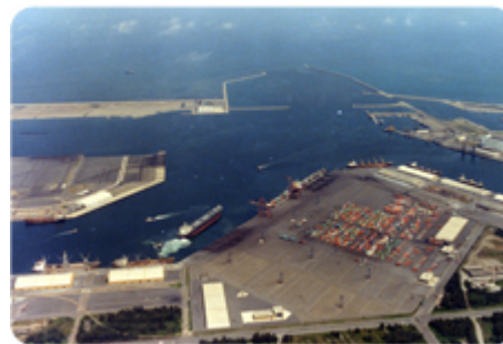
圖5-2 臺中港施工照片 檔號：0062/0110117/001 案名：臺中港施工相片 來源機關：榮民工程股份有限公司 管有機關：檔案管理局
