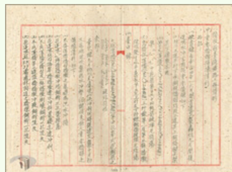
圖1：接收前臺灣鐵路工務情形
