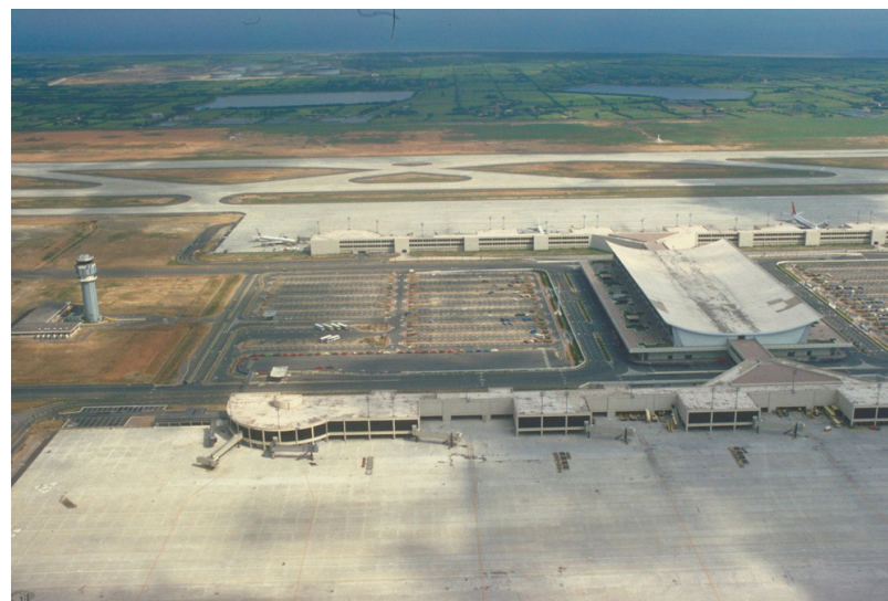
圖2 民國66年施工中的桃園國際機場
