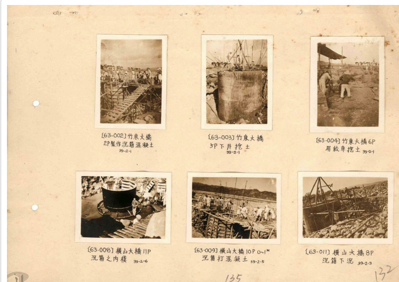
圖11 竹東與橫山大橋施工情形
