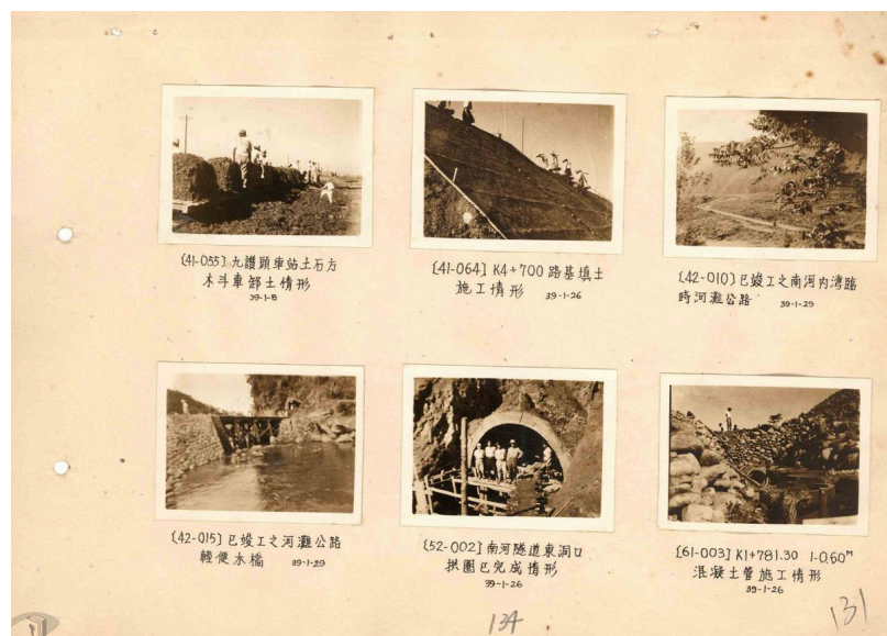
圖10 內灣支線施工一隅
