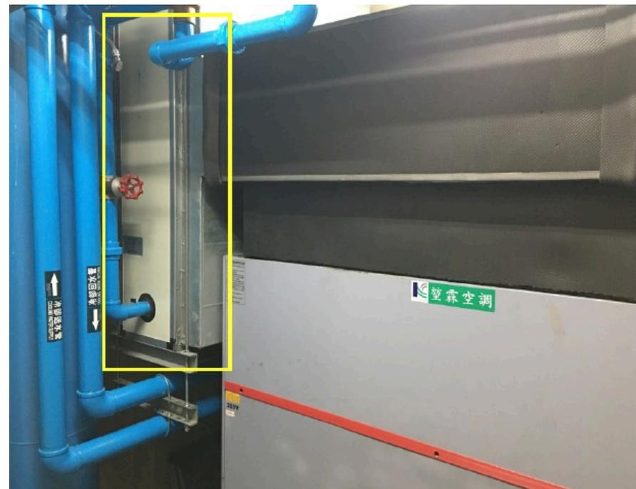
圖10 空調箱型機設置廢熱回收盤管再利用
