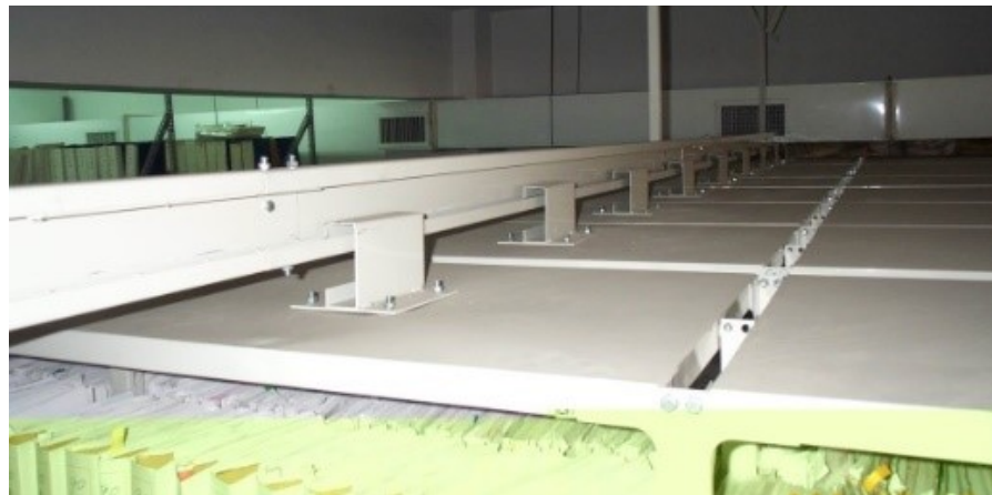
圖3 檔案架上方設置防傾倒卡榫
