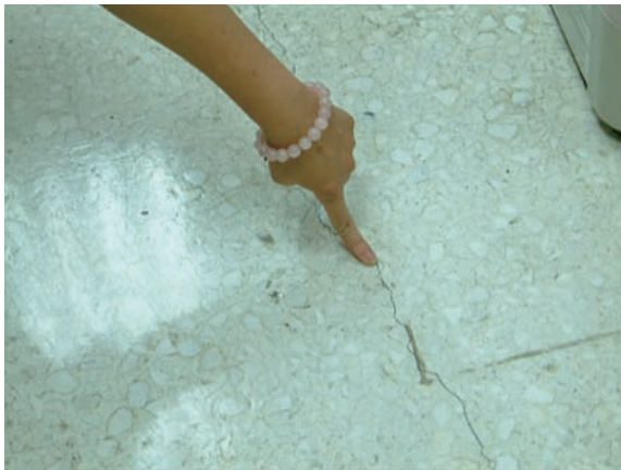
圖 23 地板超載產生裂縫之情形 ( 不良案例 )
