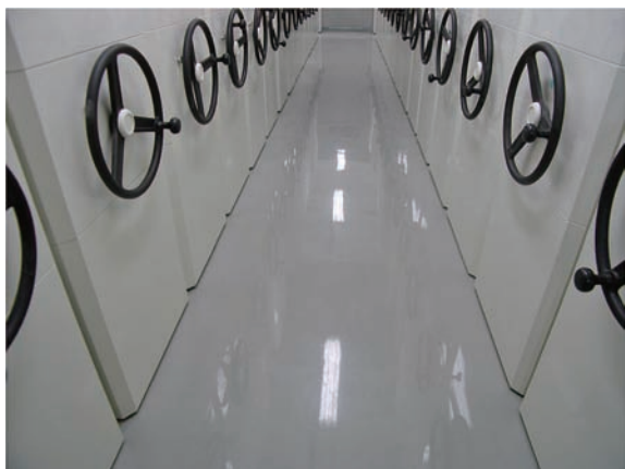
圖 19 環氧樹脂 (EPOXY) 地坪
