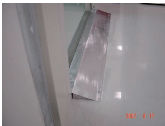
圖 22 不鏽鋼緩坡處理方式
