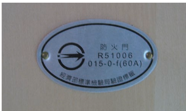
圖 16 1 小時以上防火時效「f (60A)」門窗的認證參考圖樣
