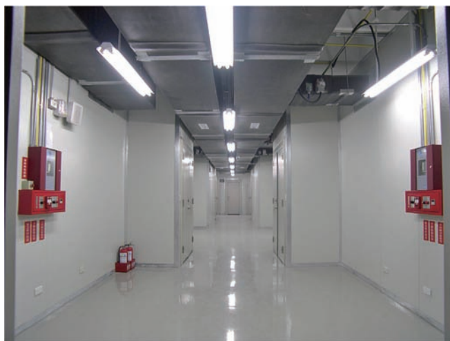
圖 13 採用金屬庫板方式處理之分間牆案例
