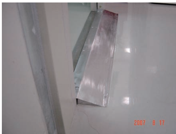
圖 22 不鏽鋼緩坡處理方式
