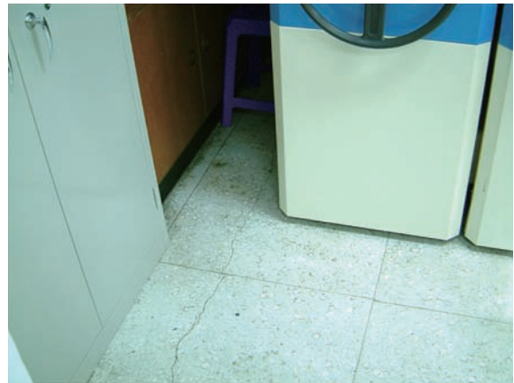
圖 23 地板超載產生裂縫之情形 ( 不良案例 )
