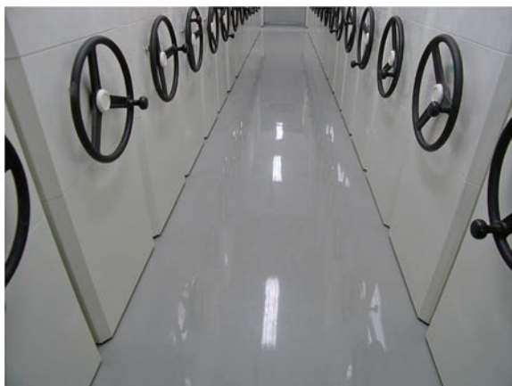
圖 19 環氧樹脂 (EPOXY) 地坪
