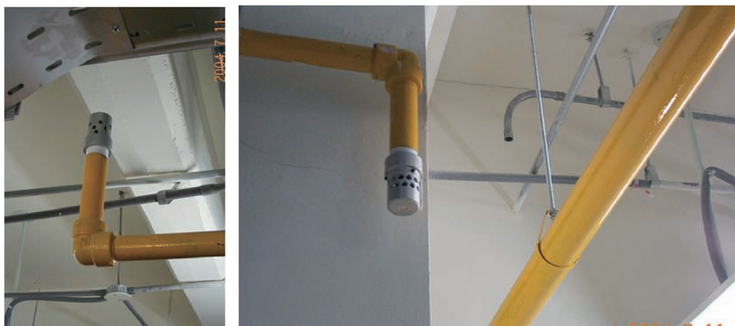
圖 52 自動氣體滅火系統噴頭
