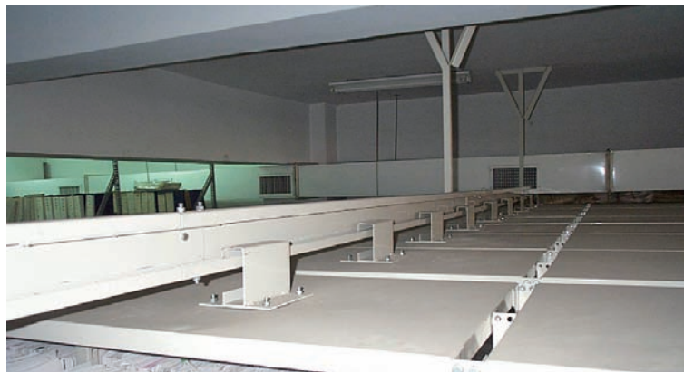
圖 79 密集式檔案架防震連桿（二）
