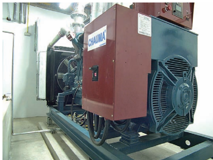
圖 88 緊急發電機
