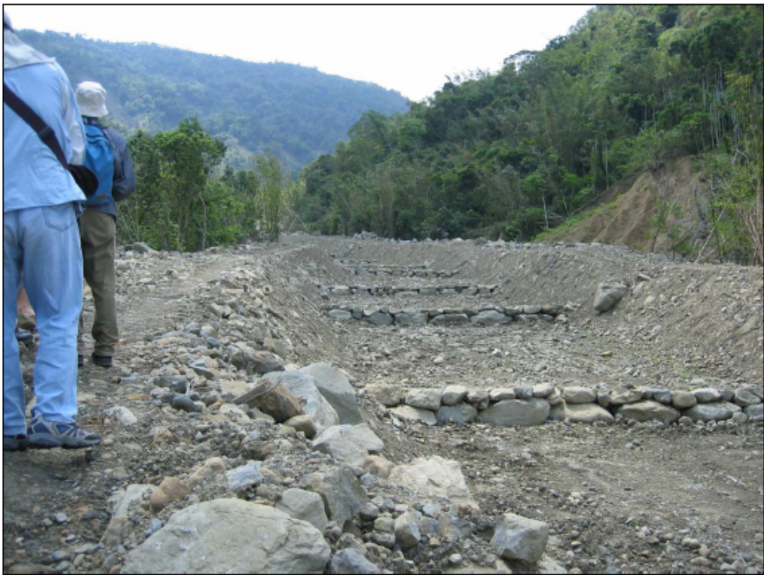
照片說明：龍蛟水溪爆發土石流，土石嚴重堆積，緊急處理後，土石嚴重裸露。
