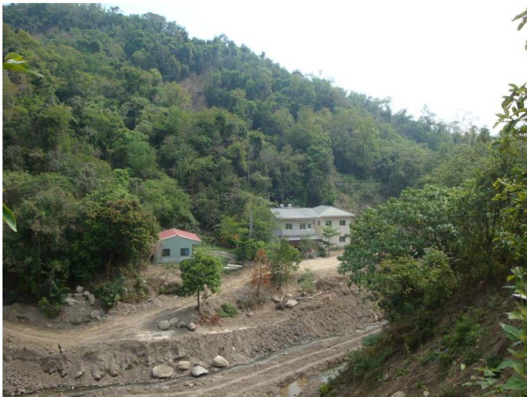
圖 5 紅水坑溪土石大量淤積造成 20 鄰屋舍淹埋
