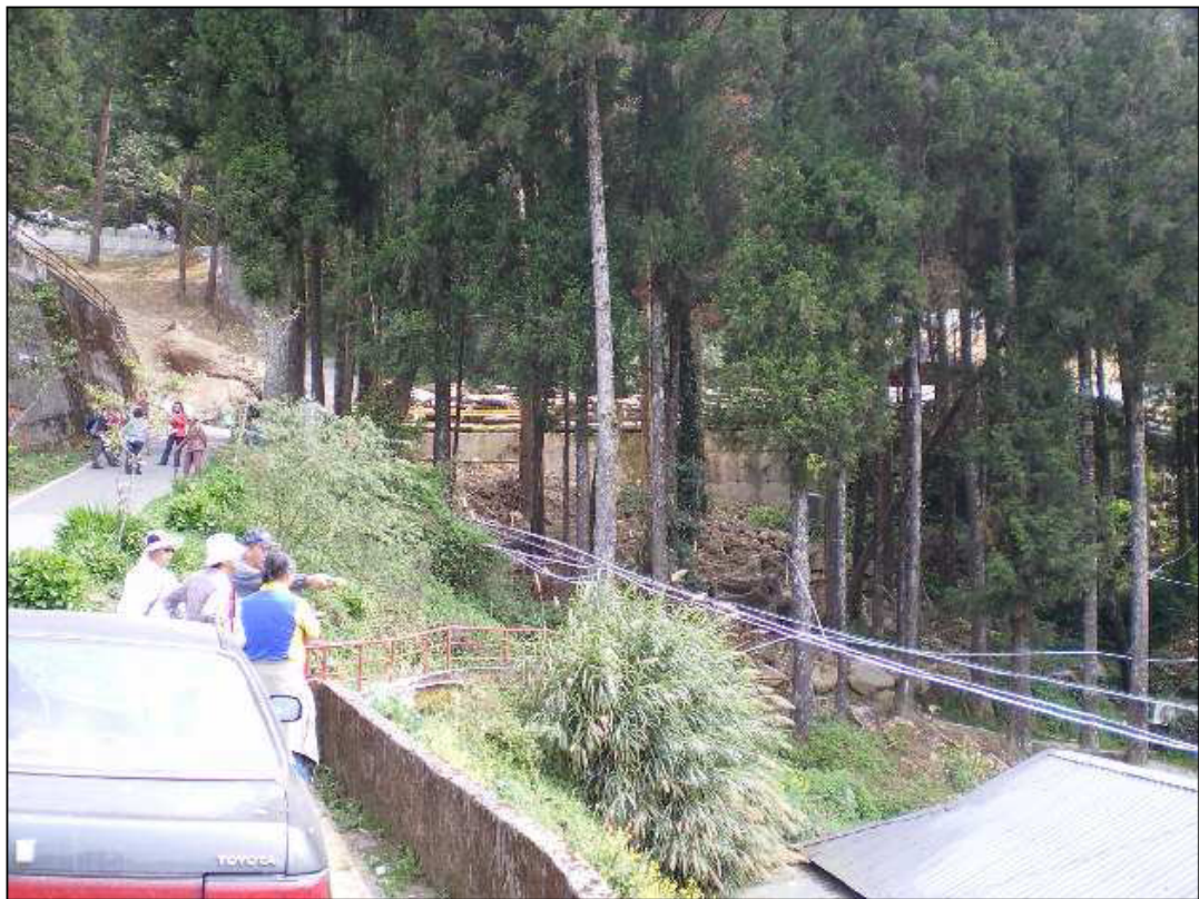
照片說明：邊坡崩塌，土石衝擊居住地並造成沿岸淤積。
