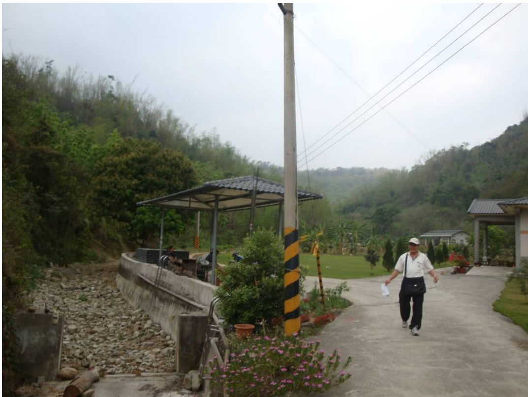
圖 4 西勢坑(12 鄰)民宅旁溪流現況二
