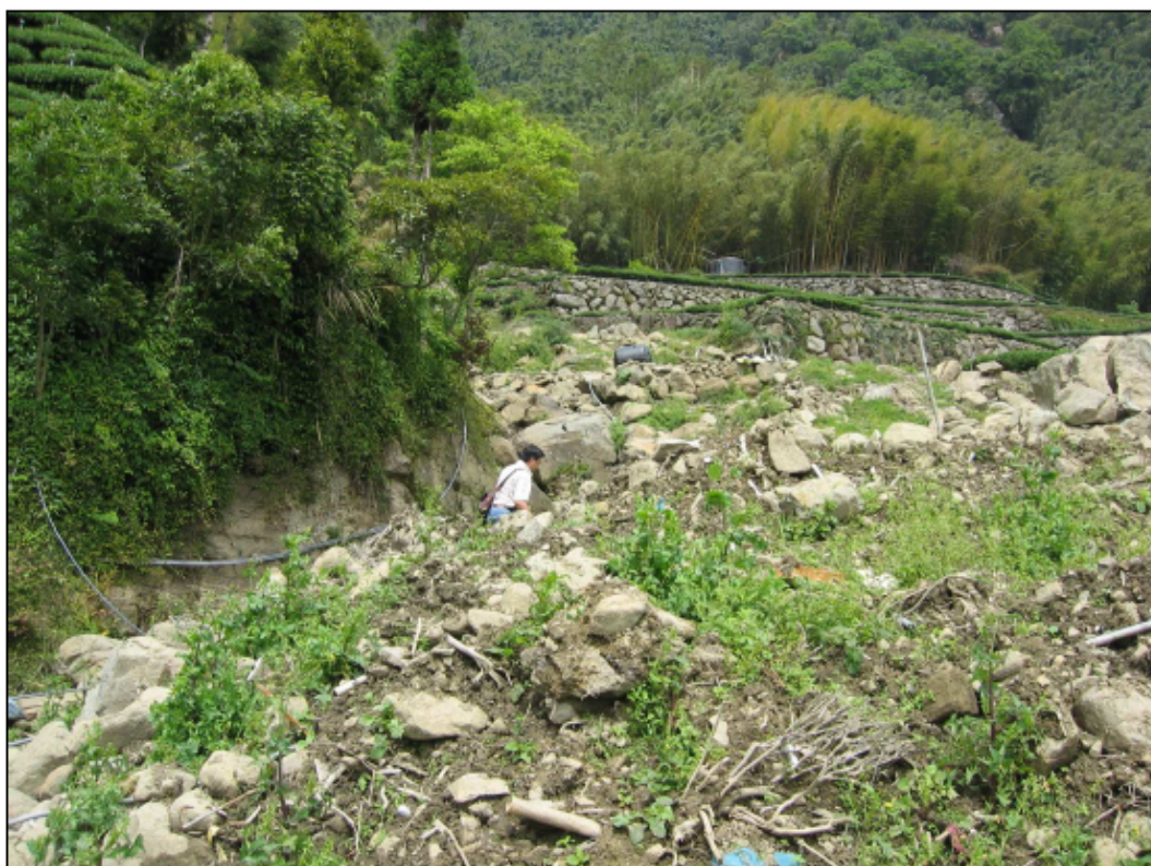
照片說明：房舍上邊坡正後方，野溪發生土石流，河道轉彎。
