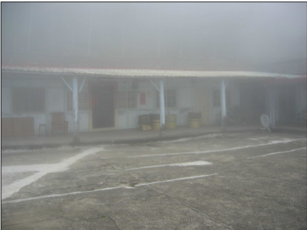
照片說明：8 鄰 4 號地表及建物周邊無明顯災害跡象。
