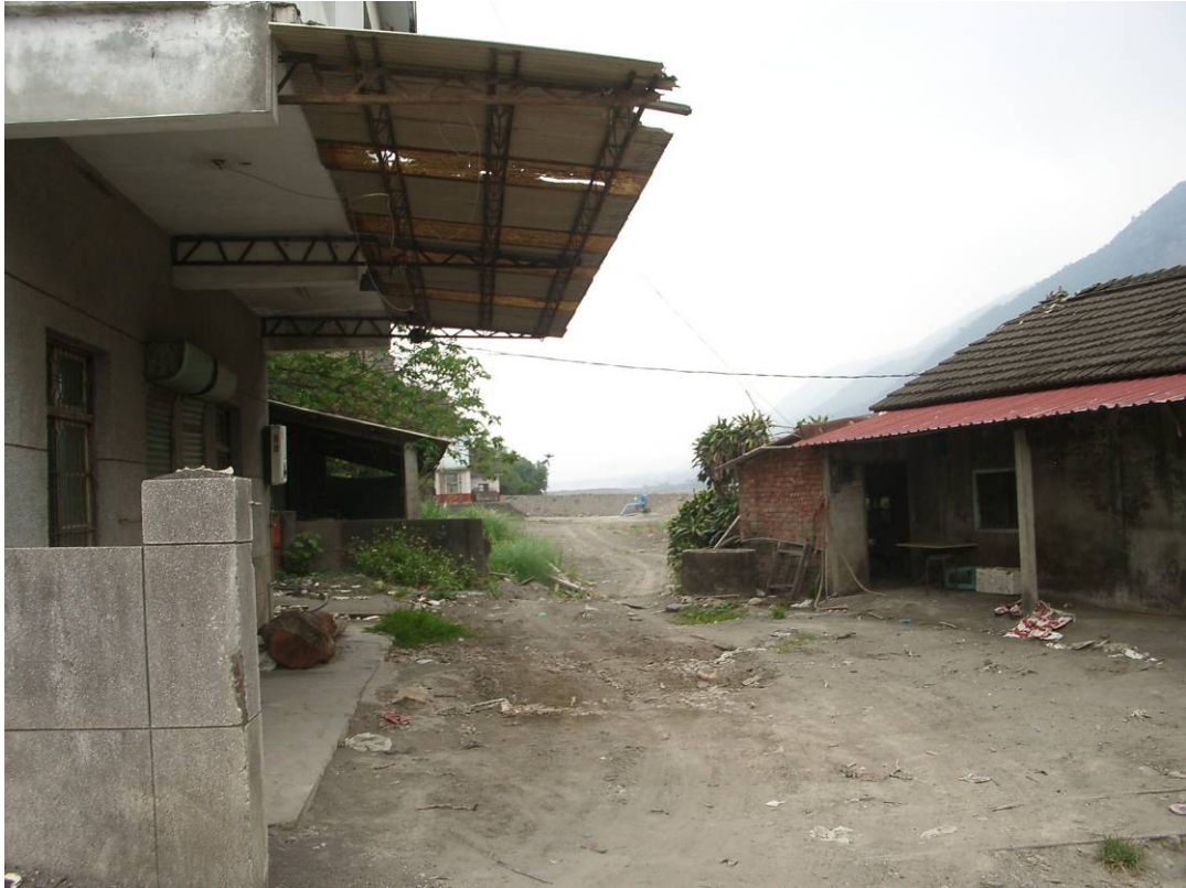
圖 7 一隧地區(12 鄰)受災民宅現況
