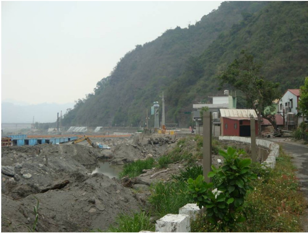
圖 5 1 鄰旁未清淤之河道
