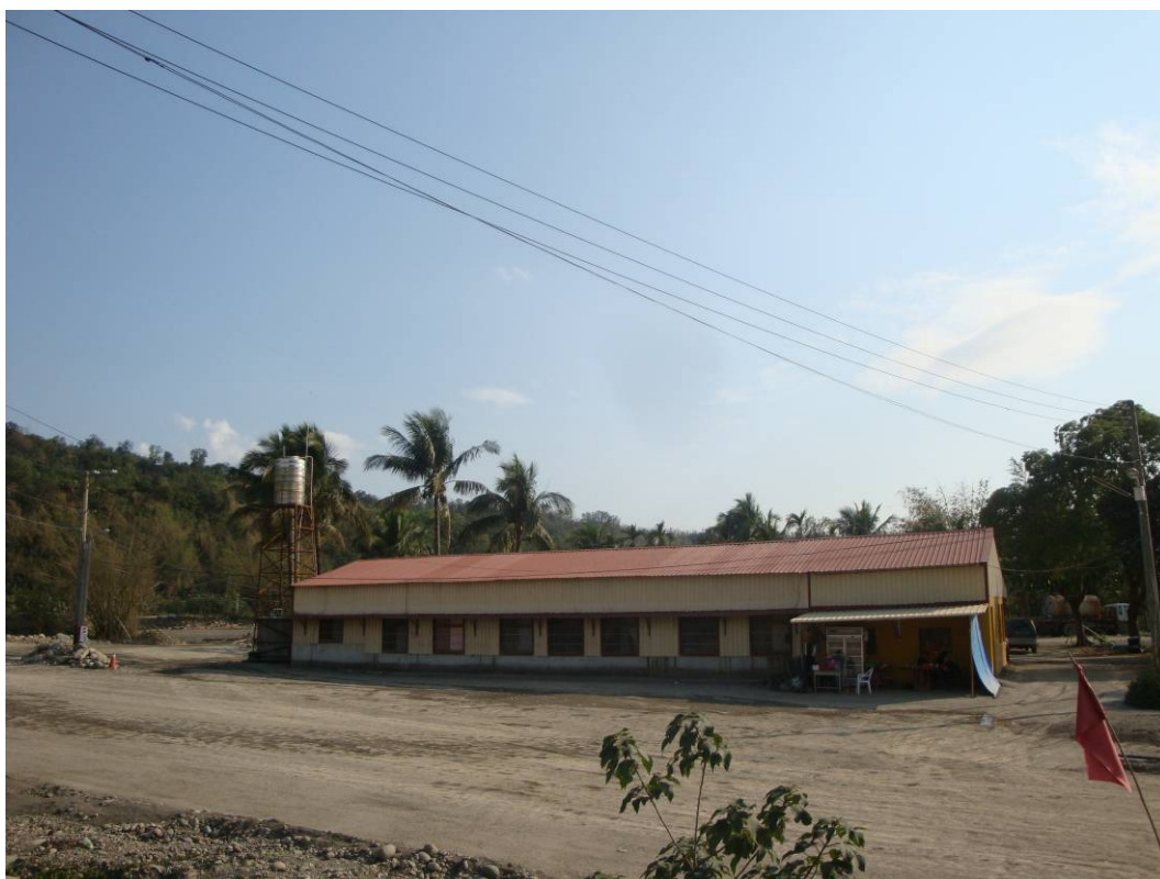
圖 4 中園路(4 鄰)、田寮巷(8 鄰)民宅均嚴重淹水，部分民宅遭土石掩埋
