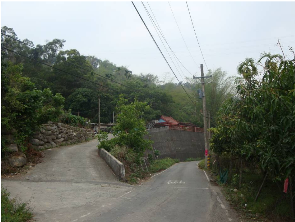
圖 6 9 鄰民房後方之邊坡
