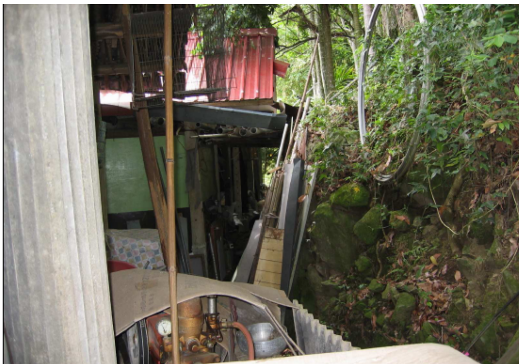
照片說明：梅山鄉太和村 3 鄰 8-3 號房舍後方擋土牆無明顯變形破損。
