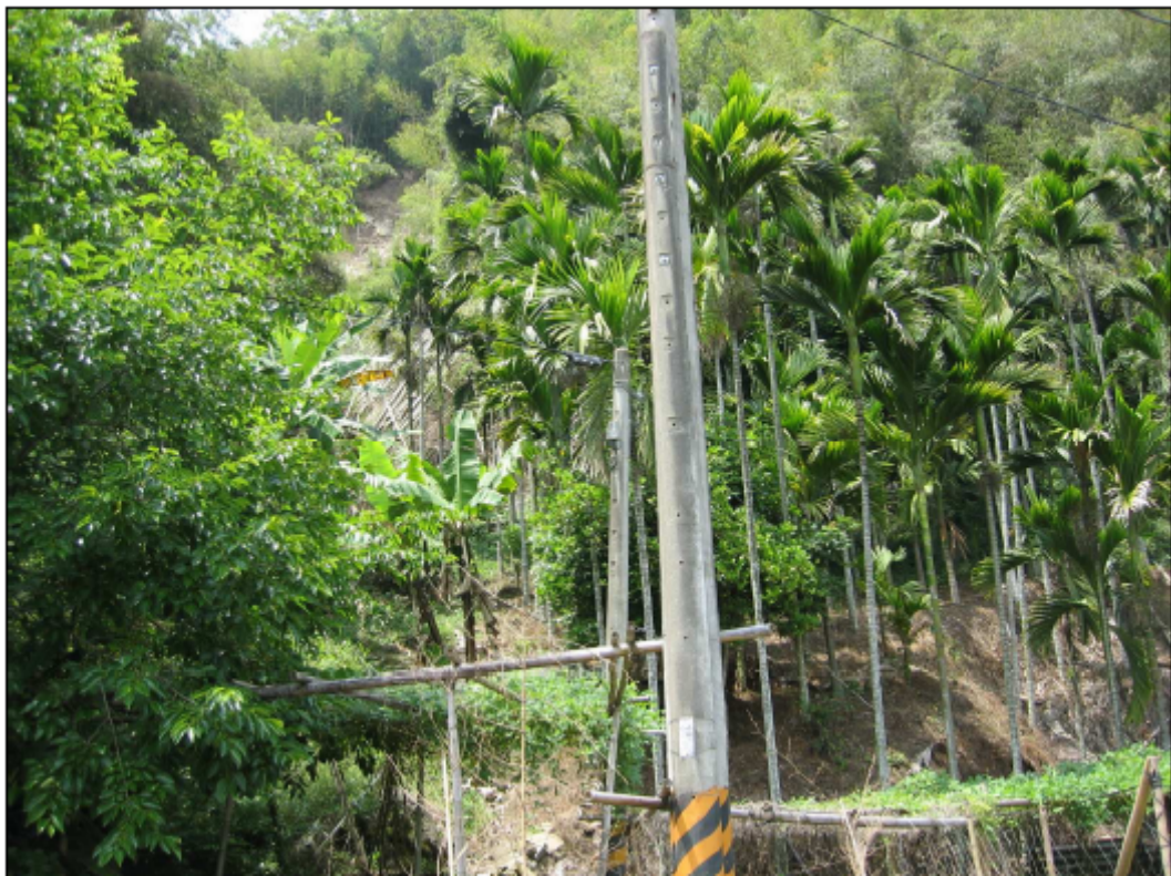
照片說明：梅山鄉太和村 3 鄰 37 號房舍後方右側坑溝明顯崩塌。
