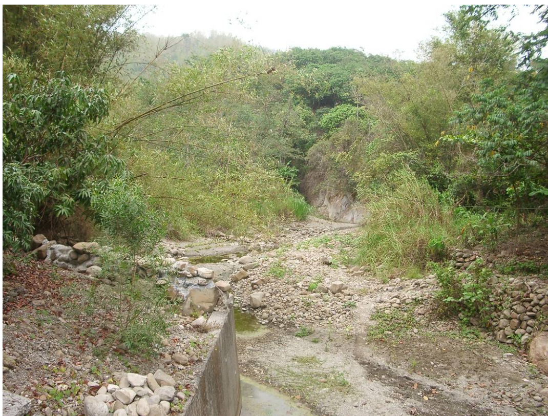
圖 5 西勢坑(13 鄰)上游民宅旁溪流現況
