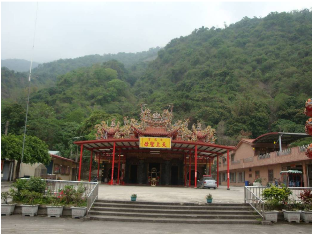
圖 8 5 鄰聚落民房(津鳳宮)後方之邊坡
