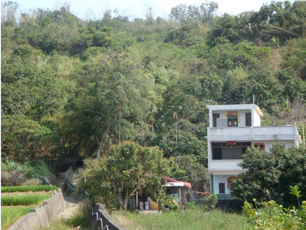
圖 4 寶隆村 11 鄰旁大排水溝
