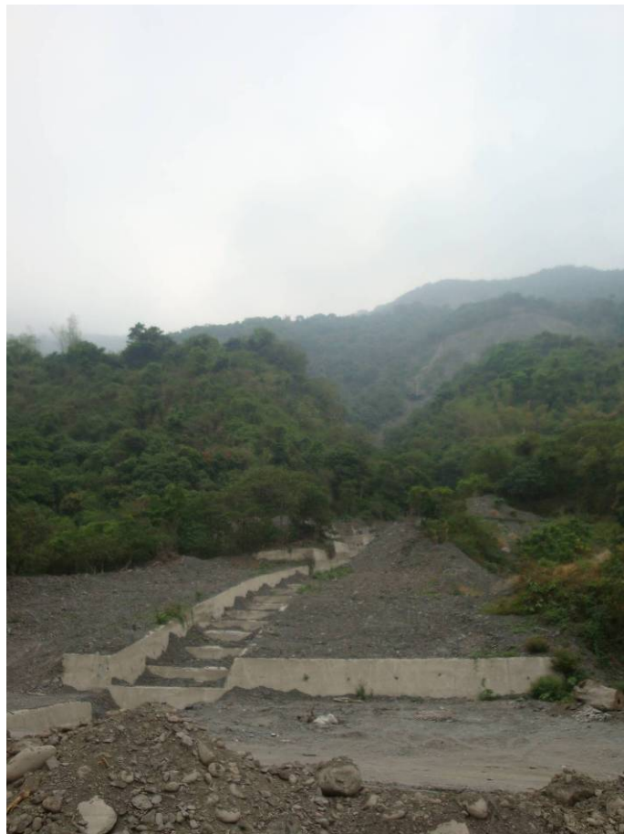
圖 10 6 鄰旁之土石流整治工程
