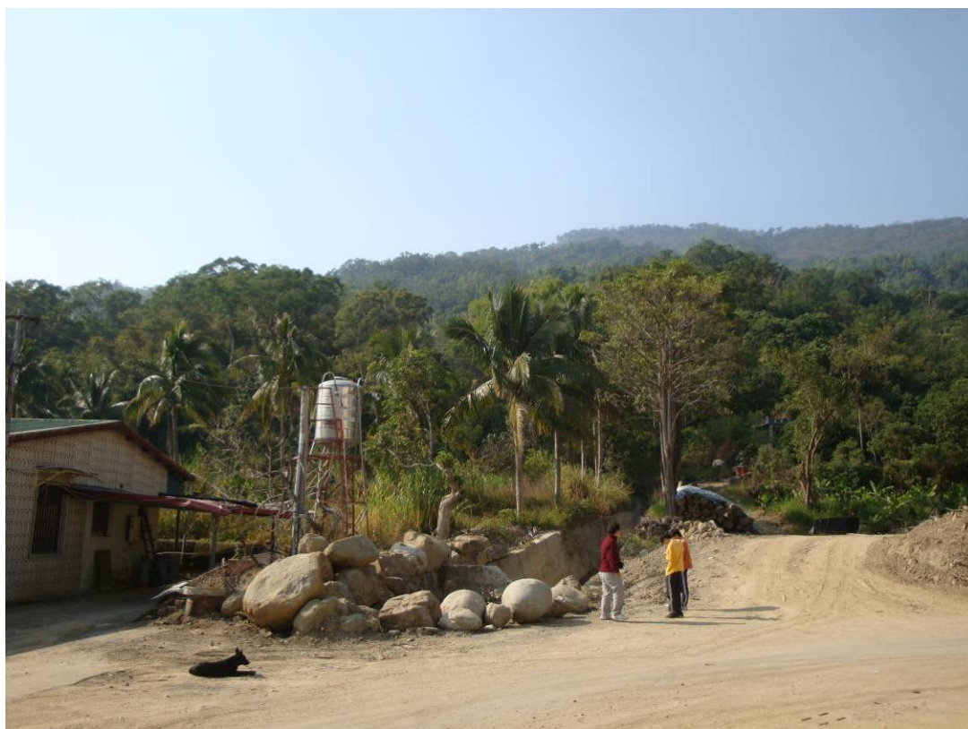
圖 6 新興路(20 鄰)：土石流潛勢溪流(DF012)再次發生，掩埋下游溝渠、道路(已清理)
