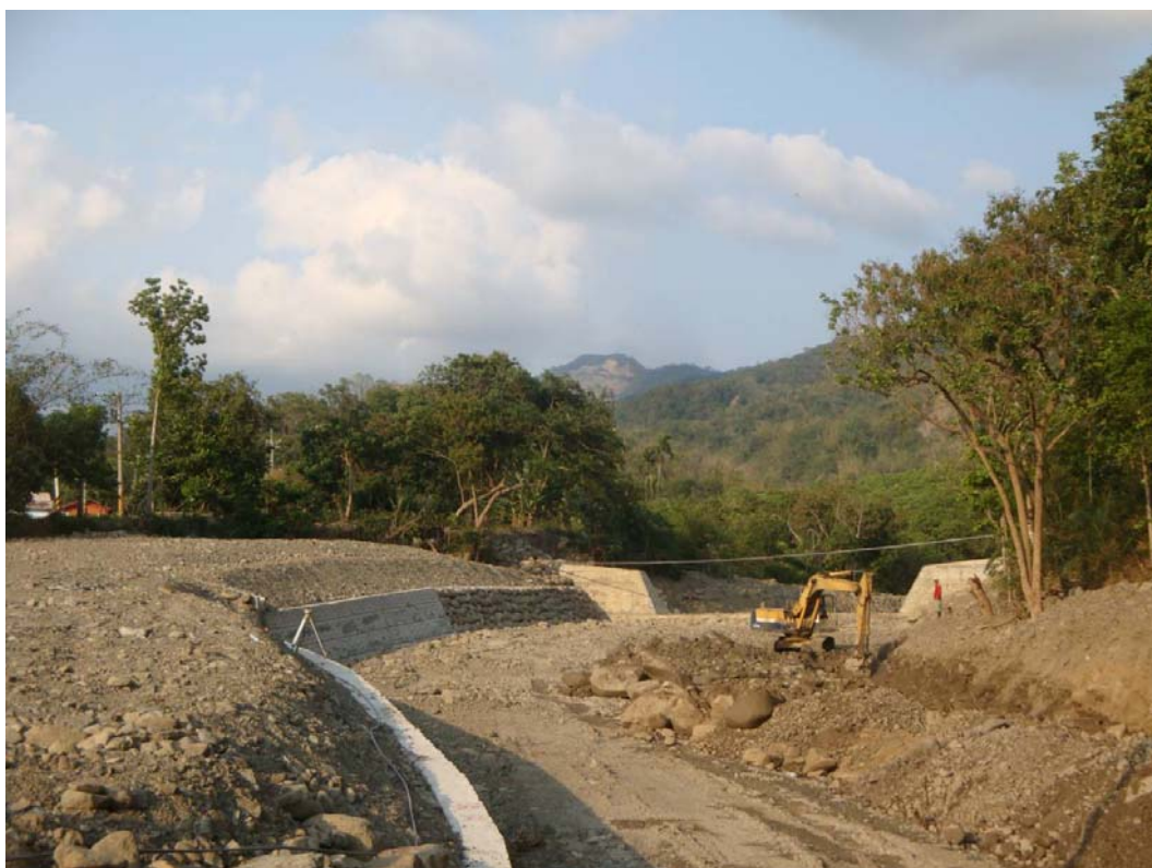
圖 5 班芝埔溪目前疏浚情形
