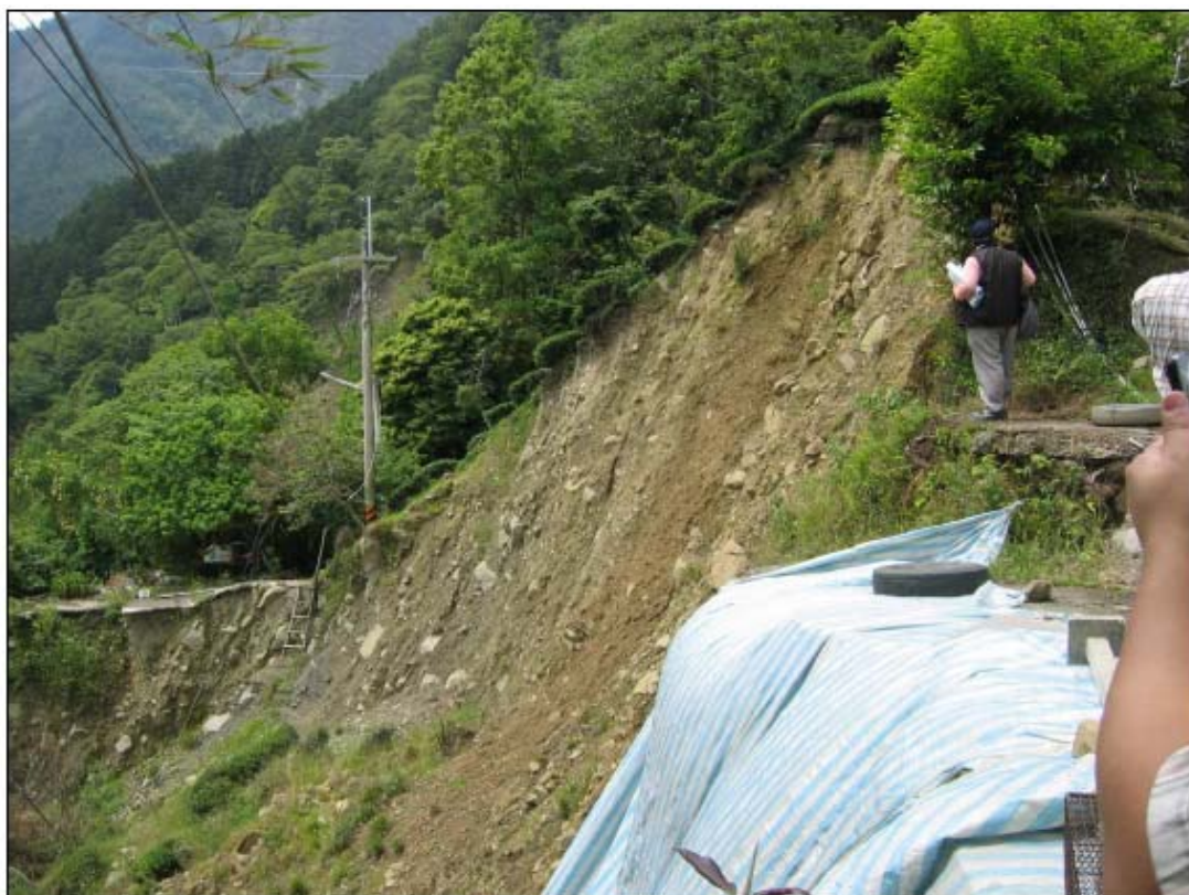
照片說明：房舍後方下邊坡崩塌，範圍向建築物擴張與接近。
