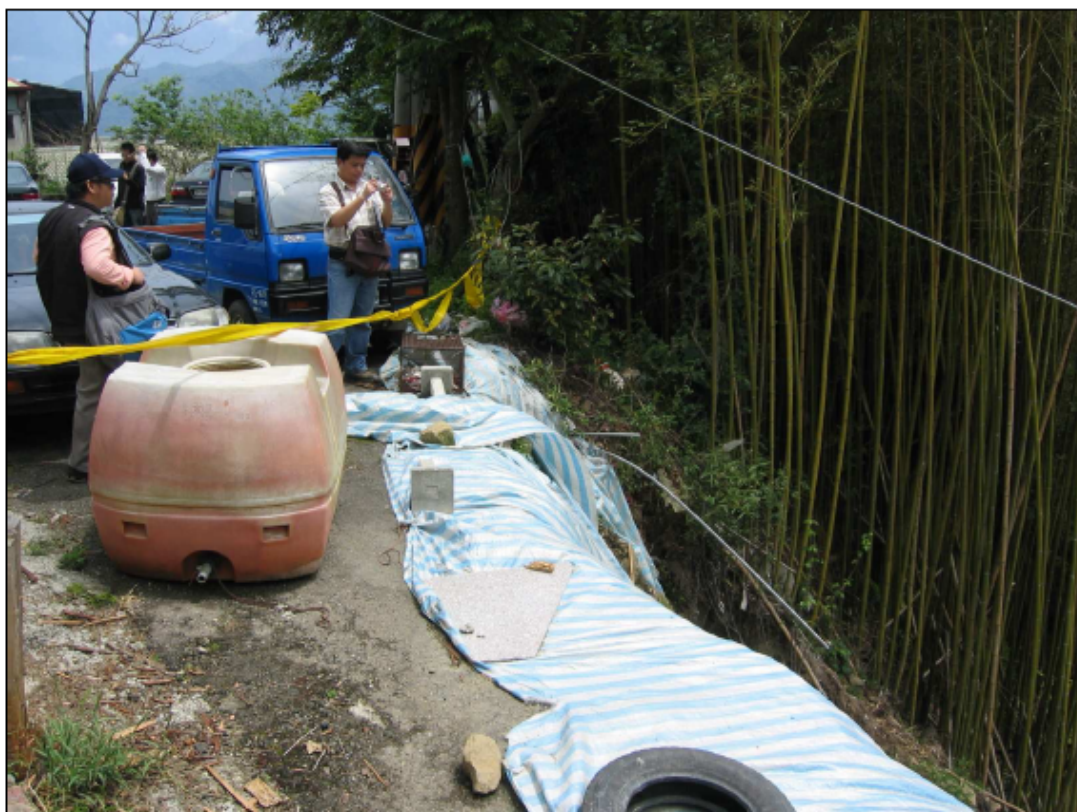
照片說明：房舍後方下邊坡崩塌，崩塌邊緣與建築物距離相近。
