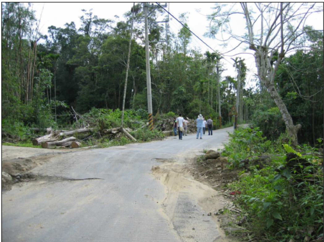
照片說明：野溪相函授漂流木堵塞，溢流水造成下方民宅淹水與土砂淤積。
