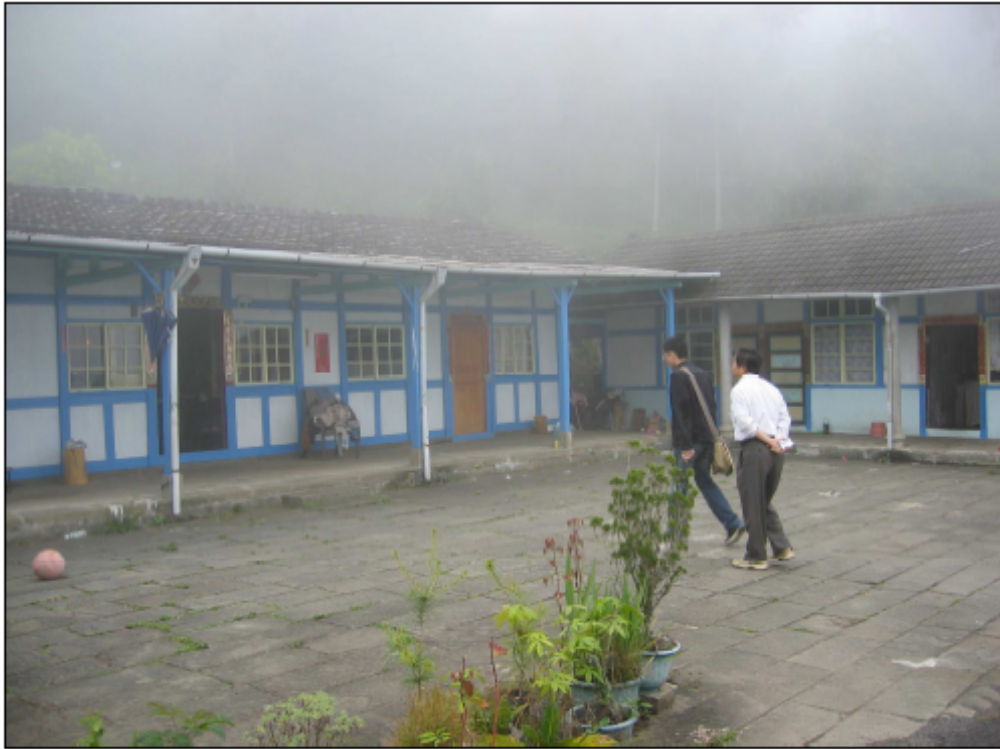
照片說明：8 鄰 3 號地表及建物周邊無明顯災害跡象。
