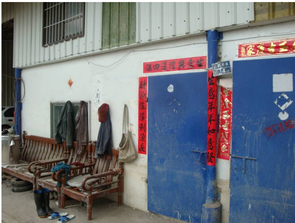
圖 7 1 鄰民房殘留淹水痕跡
