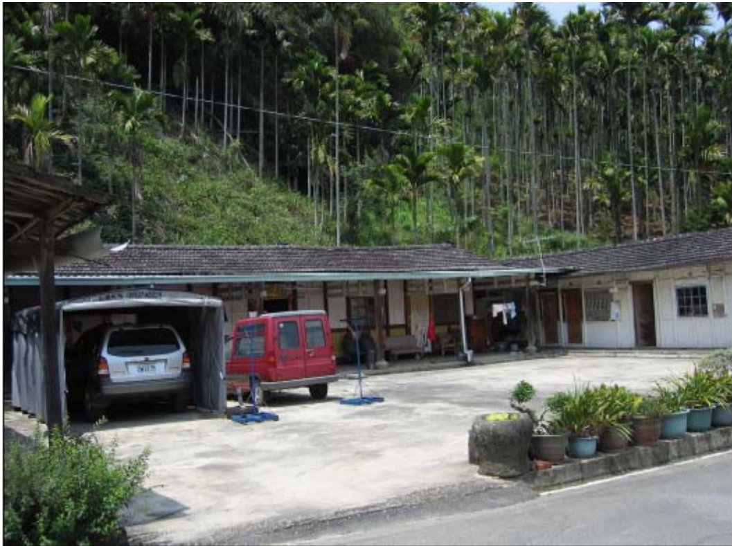
照片說明：梅山鄉太和村 3 鄰 37 號房舍後方坡地陡峭。
