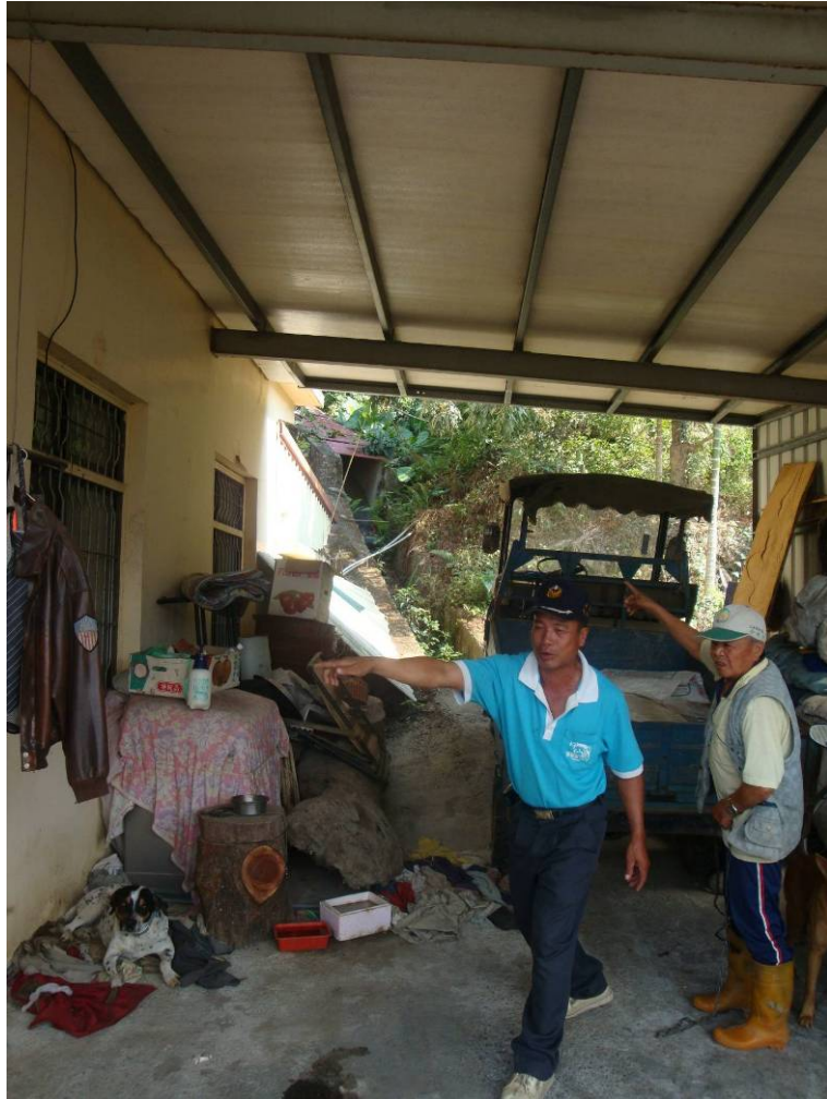
圖 6 因後方道路排水溝排水不良至路面逕流漫入寶隆村 6 鄰民房，且路面有湧水現象
