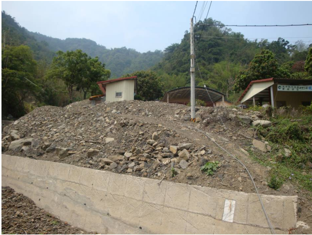
圖 11 木瓜坑河床明顯淤積，雖進行清淤，但土石量仍龐大
