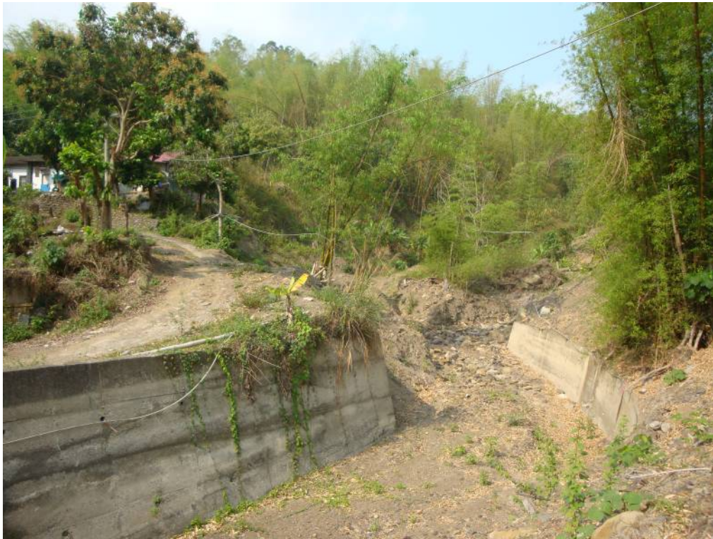
圖 3 土石淤積造成河床抬高
