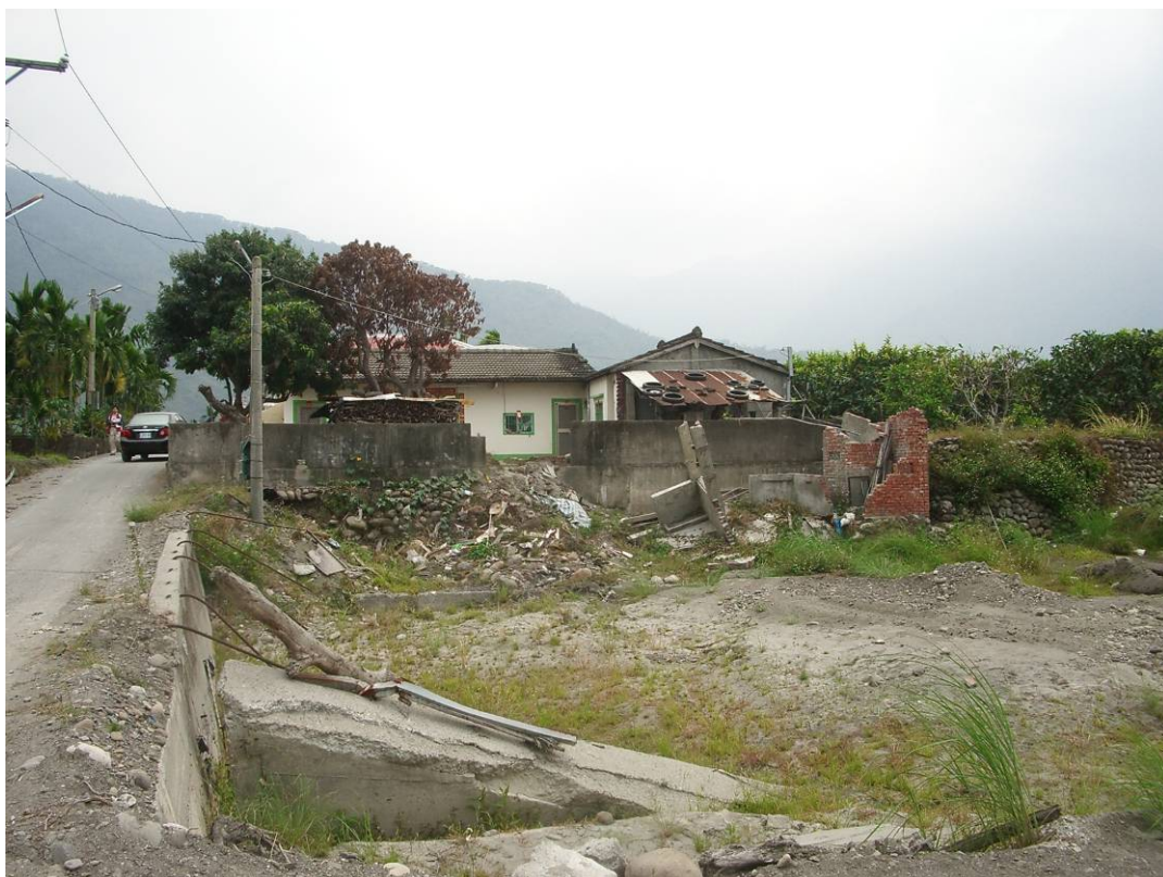
圖 3 溪埔地區(7)鄰受災損民宅
