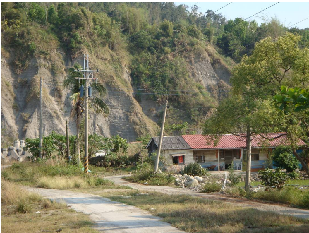
圖 5 中園路(4 鄰)、田寮巷(8 鄰)民宅均嚴重淹水，部分民宅遭土石掩埋
