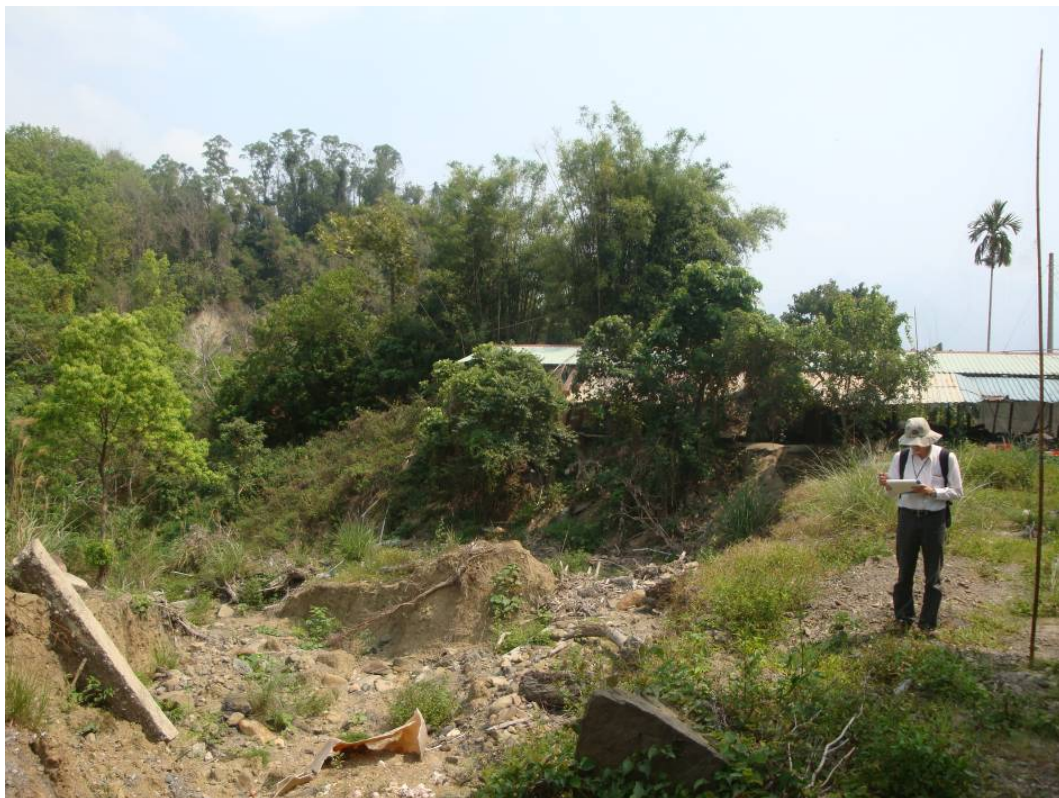
圖 6 土石大量淤積危及 15 鄰沿岸屋舍
