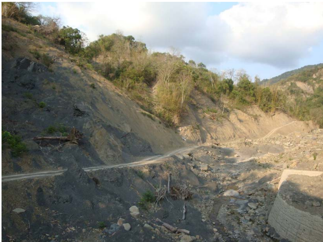
圖 3 班芝埔溪上游崩坍及淤積情形
