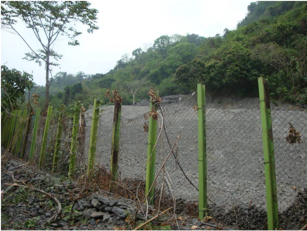
圖 9 5 鄰聚落民房(津鳳宮)後方之邊坡崩塌
