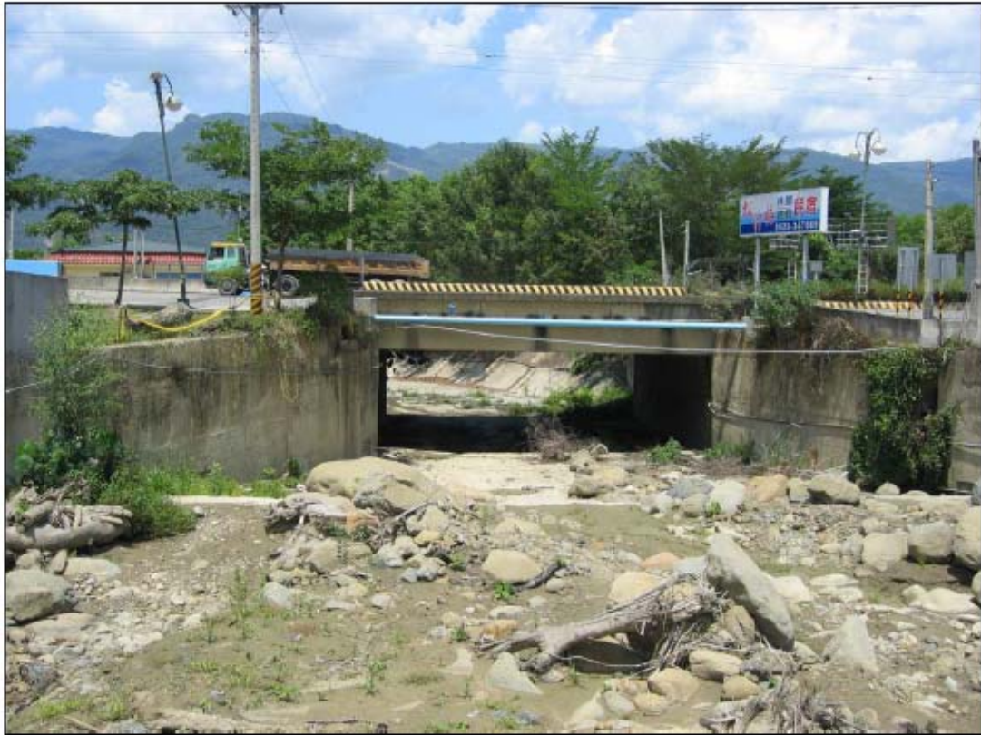
照片說明：省道台三線神斧橋通水寬度約 15 公尺，河道寬度已明顯束縮。
