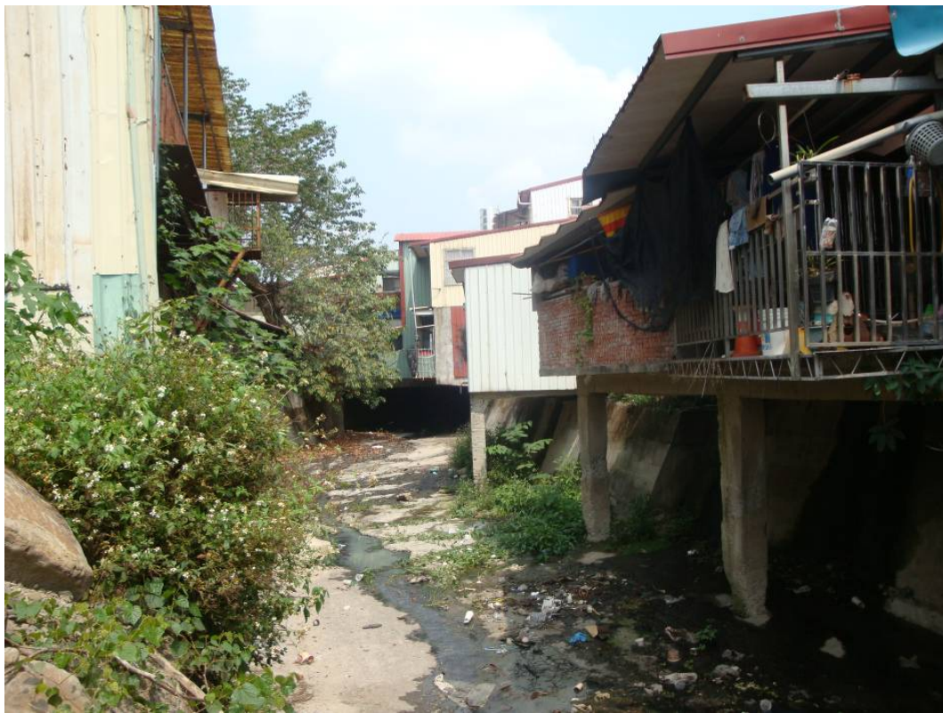
圖 9 下游 14 鄰民宅明顯佔用河道，導致河道淨高、淨寬不足
