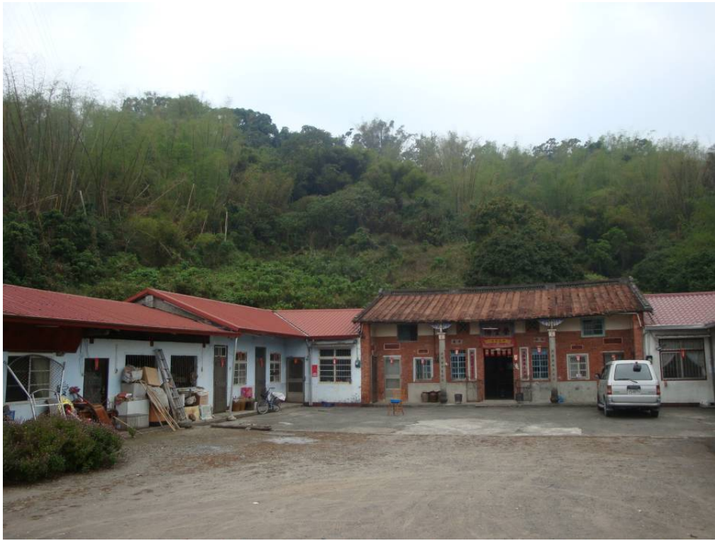
圖 5 9 鄰民房後方之邊坡
