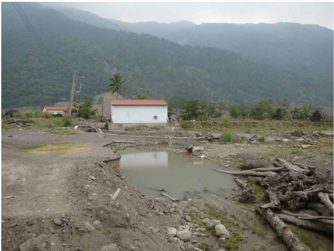
圖 6 一隧地區(12 鄰)受災後現況
