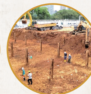
圖 1-20 國家檔案館施工情形—土方開挖(110.7.13)
