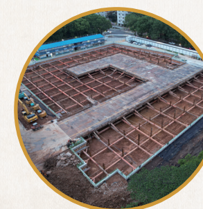
圖 1-21 第 1 階段支撐及構臺(110.8.17)
