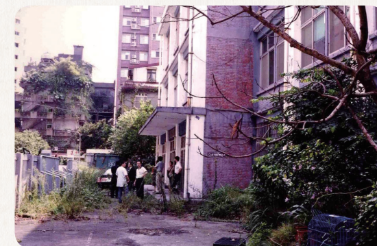
圖1-5 國防部聯合勤務總司令部管有新雄營區修繕前樣貌
