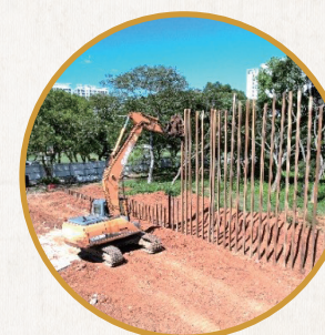
圖 1-19 國家檔案館施工情形—鋼軌樁打設(110.6.18)
