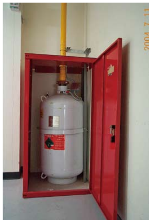
圖 47 自動氣體滅火系統鋼瓶
