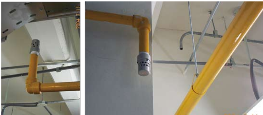
圖 48 自動氣體滅火系統噴頭
