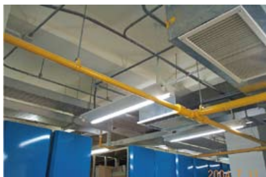
圖 46 自動氣體滅火系統管線（黃色）
