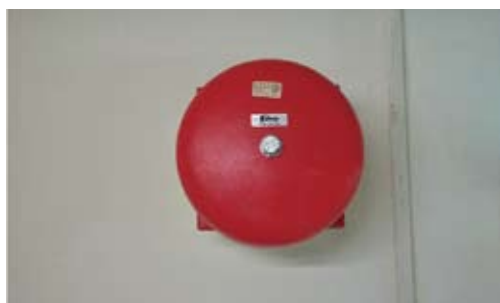
圖 45 自動氣體滅火系統警報器
