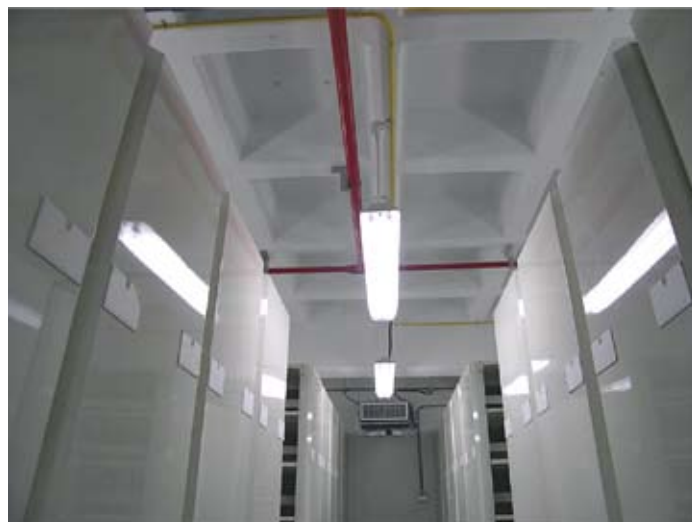
圖 14 不設懸吊式天花板 (紅色管線為消防管線、黃色管線為電力管線)
