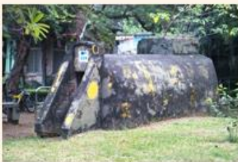
圖3 臺南公園內設置的防空洞。
