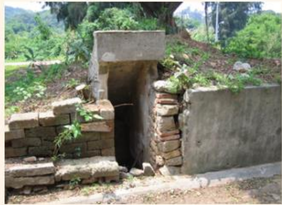
圖1 道路旁設置的地下式防空洞。
