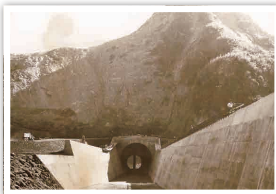
圖 11 49 年 12 月導水隧道出口導槽完工照 資料來源：北水局（1960 年 12 月 31 日）
