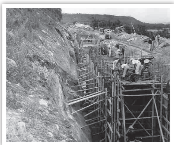
圖 18 石門大圳幹渠沿山麓邊坡開挖施工照片
