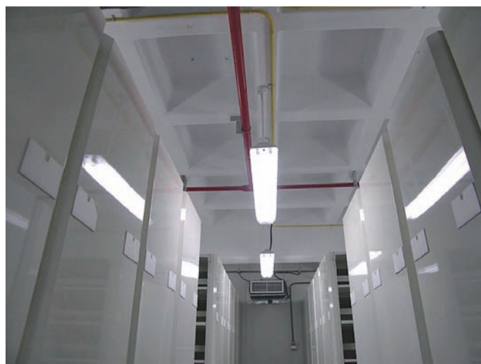
圖 18 未設懸吊式天花板 ( 紅色管線為消防管線、黃色管線為電力管線 ) 之檔案庫房案例
