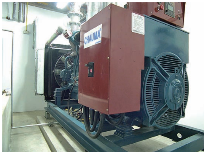
圖 88 緊急發電機
