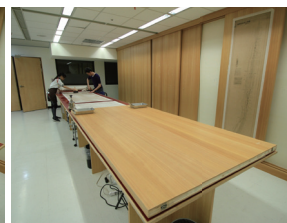
圖 28. 重疊活動牆板 (桌面上牆方式)
