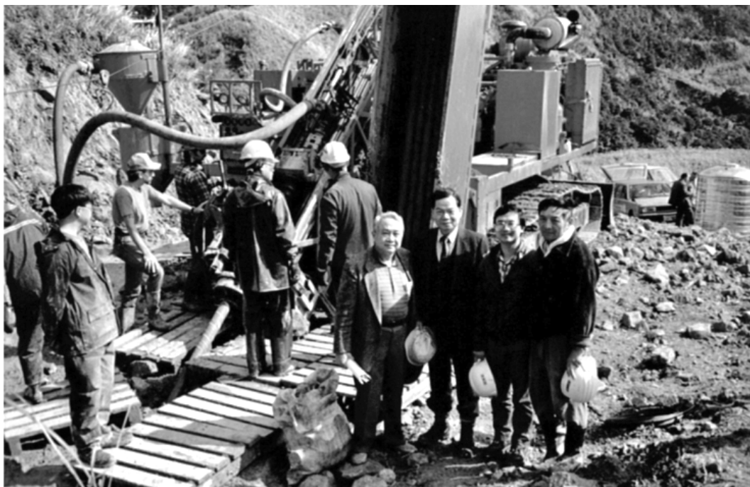
圖 49 民國 80 年逆循環鑽機在金瓜石金礦進行探勘
