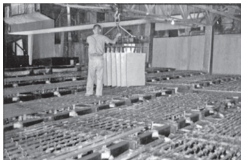
圖 34 臺金公司煉銅廠內電解銅作業
