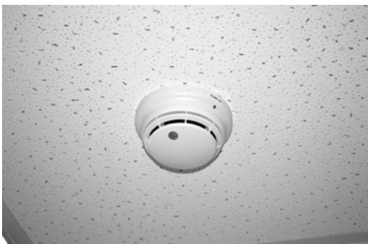
圖 11 偵煙探測器
