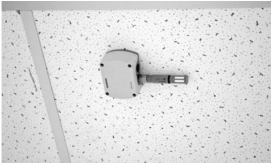
圖 7 溫溼度探測器
