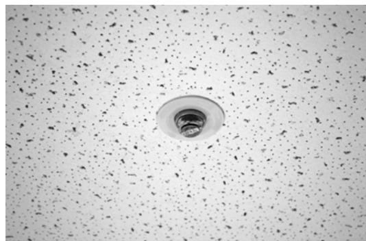
圖 12 自動撒水系統撒水頭
