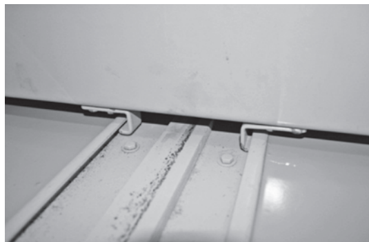
圖 14 埋入式軌道與防傾倒裝置
